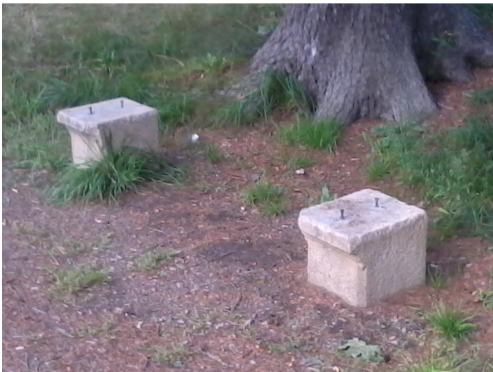
Obrázek 17, moderní posezení bohužel nevydrželo častým útokům vandalů.
