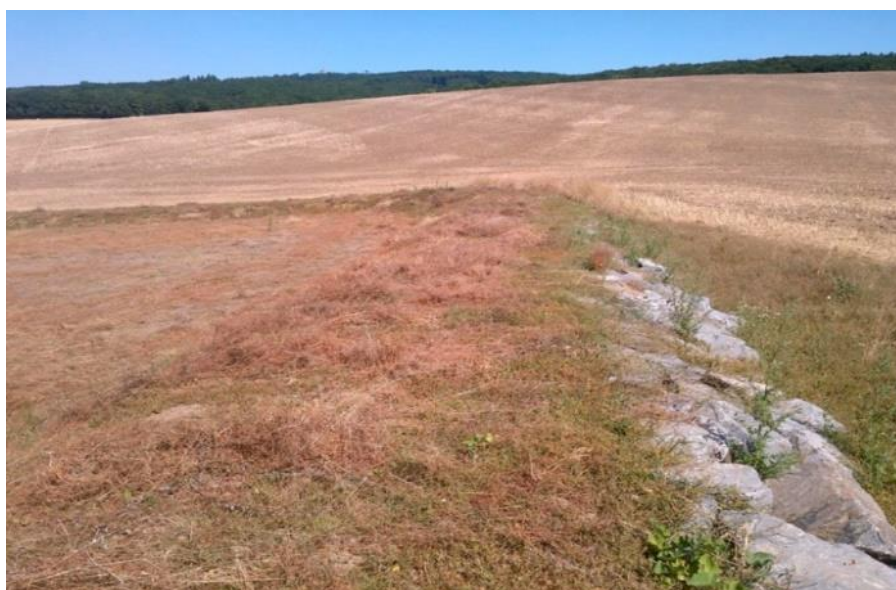
Obrázek č. 15 Protierozní hrázka (VÚV TGM v.v.i., 2018)
