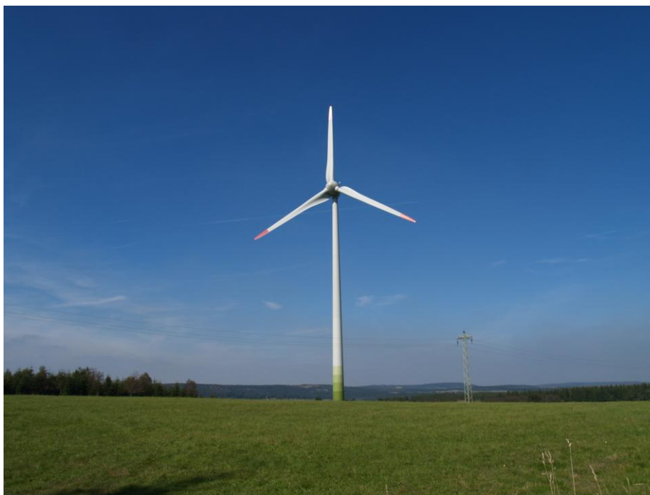
foto č. 10 Větrná elektrárna Klíny II - Sever č. 2
