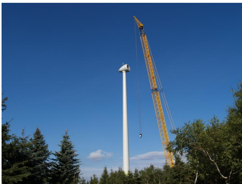
foto č. 3 Výstavba větrné elektrárny Klíny I - Jih č. 1
