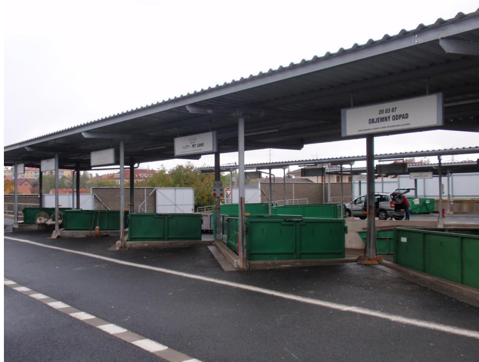
Obr. 50 – Areál sběrného dvoru na Klinkách (Šindelář, 2015)
