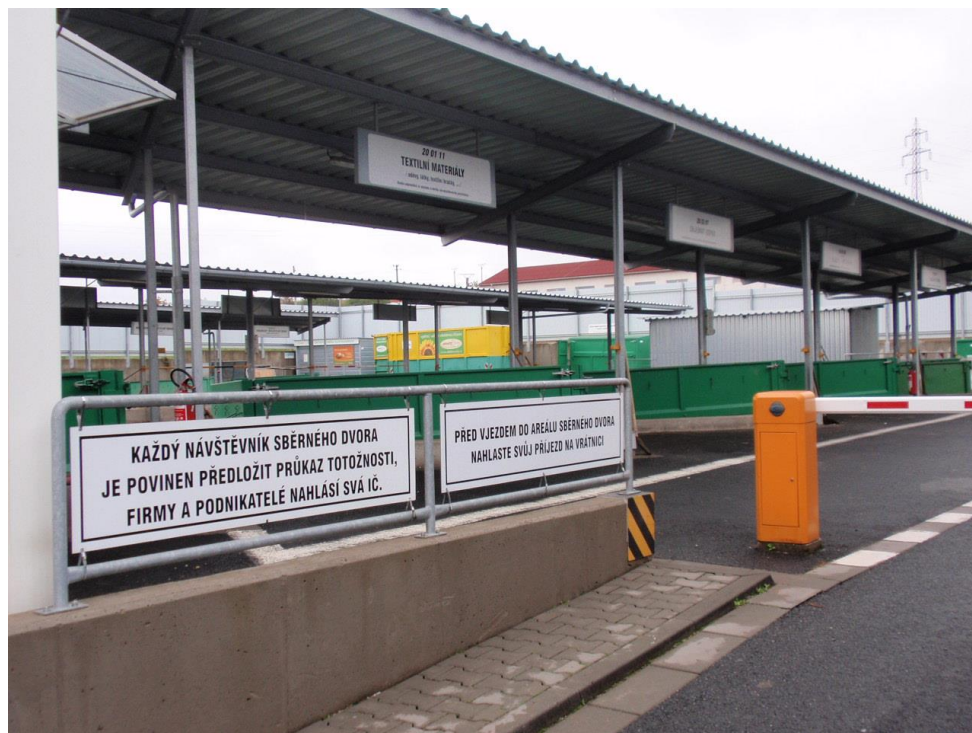
Obr. 49 – Areál sběrného dvoru na Klinkách (Šindelář, 2015)
