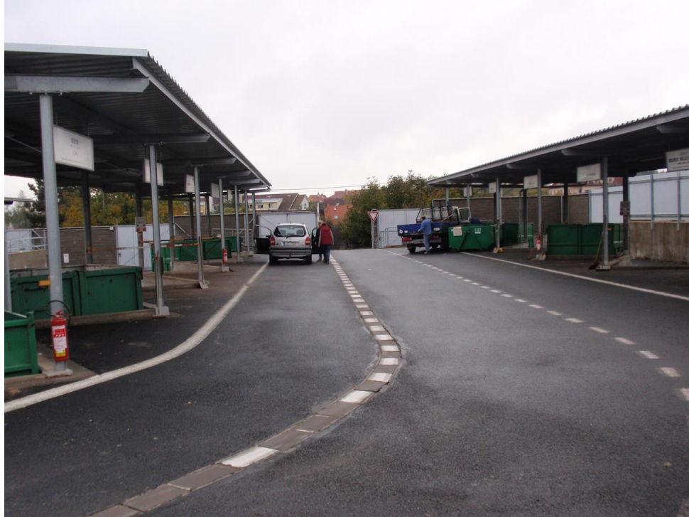
Obr. 51 – Areál sběrného dvoru na Klinkách (Šindelář, 2015)
