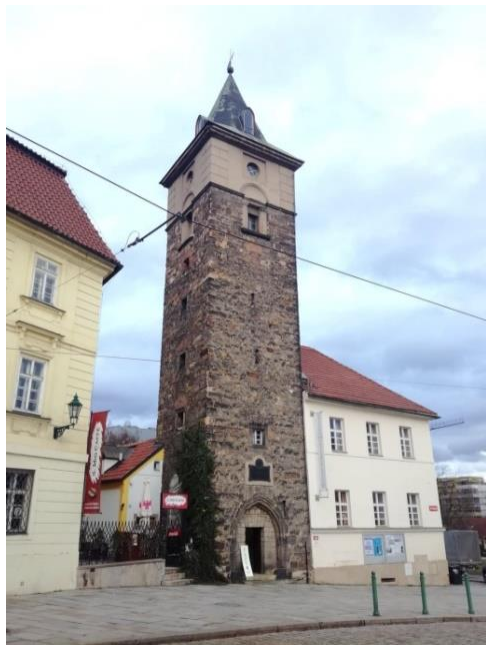
Obrázek č. 3 – Vodárenská věž – Plzeň. Zdroj: archiv autorky
