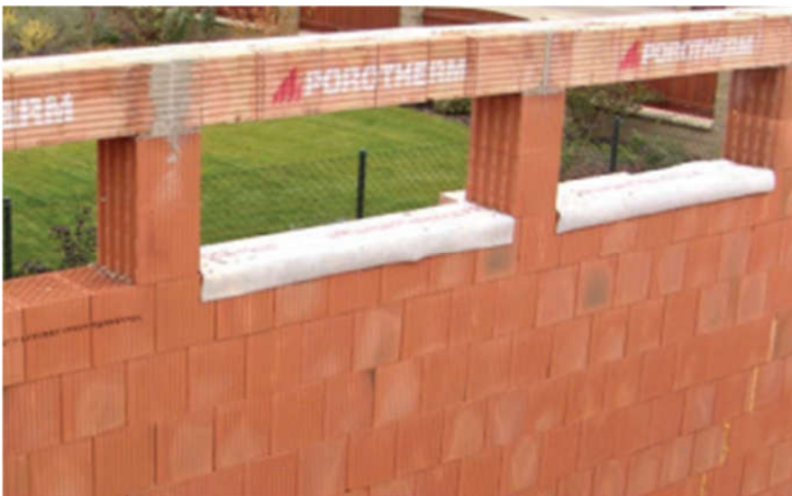
Obrázek č. 20 - Osazení překladů [2]
