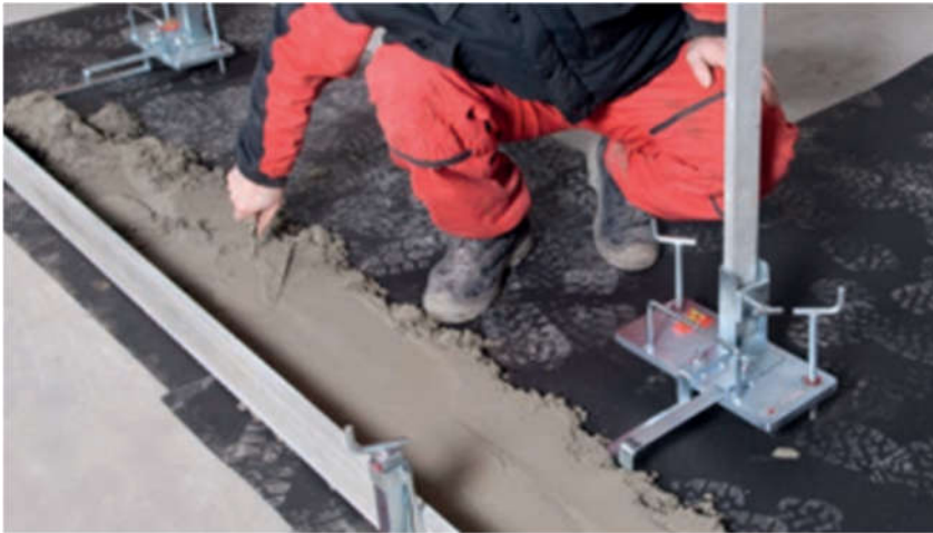
Obrázek č. 15 - Nanášení vyrovnávací malty [2]
