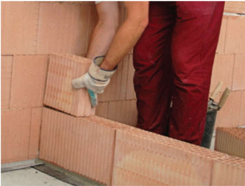
Obrázek č. 19 - Napojení příček [2]
