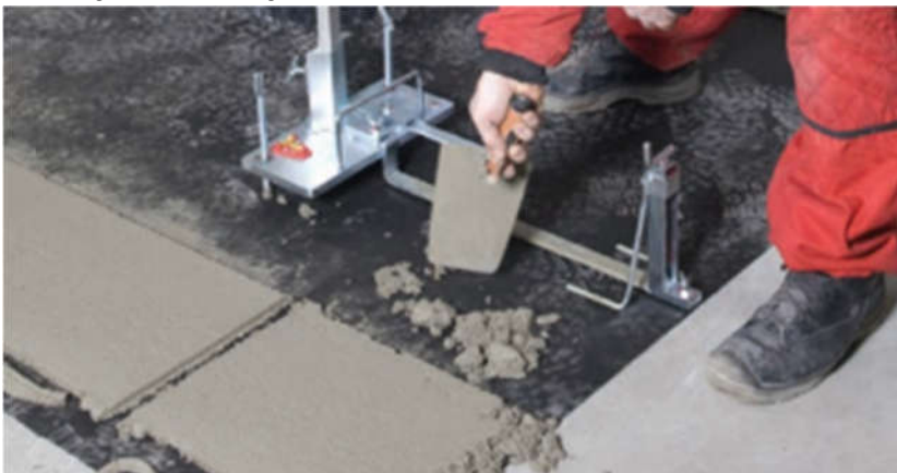
Obrázek č. 16 - Přemísťování nastavitelných přípravků [2]
