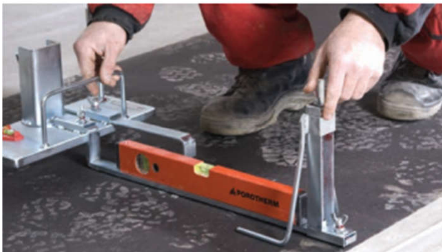
Obrázek č. 14 - Nastavení přípravku vyrovnávací soustavy [2]
