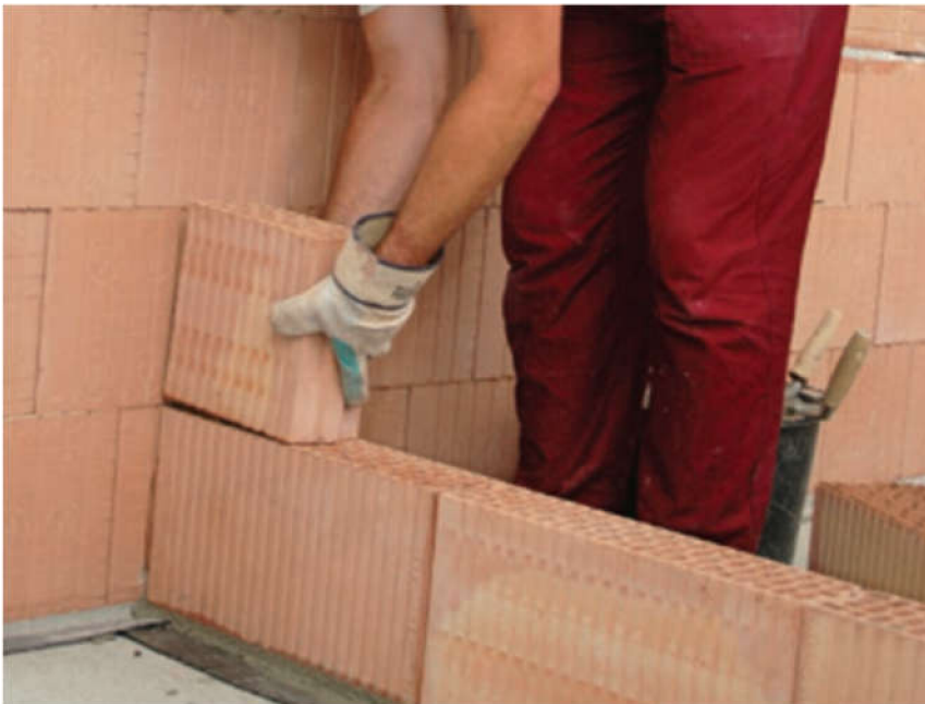
Obrázek č. 19 - Napojení příček [2]
