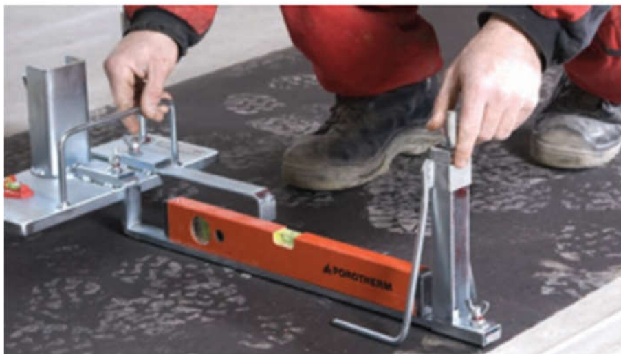
Obrázek č. 14 - Nastavení přípravku vyrovnávací soustavy [2]
