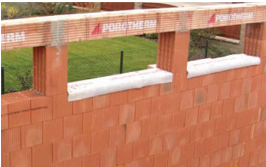
Obrázek č. 20 - Osazení překladů [2]
