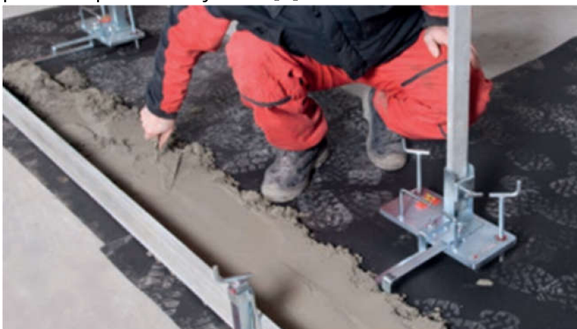
Obrázek č. 15 - Nanášení vyrovnávací malty [2]
