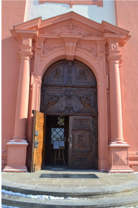
Obr. 9: detail průčelí – portál
