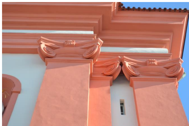
Obr. 8: detail průčelí – hlavice pilastrů
