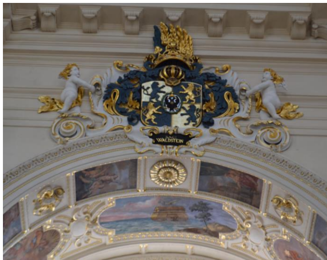
Obr. 42: Valdštejnská kaple Narození Panny Marie – alianční znak
