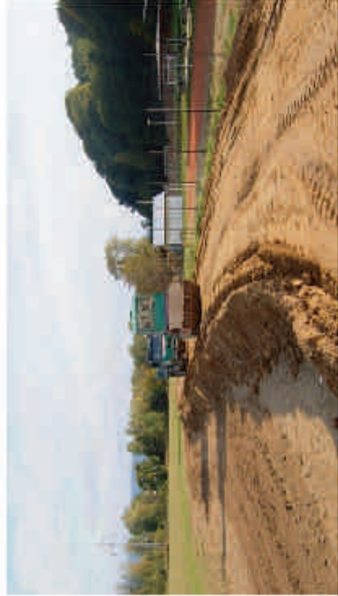
Obr. 2 - Navažka zeminy pro vybudování komunikace a rekreačního areálu zdroj: http://www.stavabni-mechanizace.cz/image_vohospodarske/
