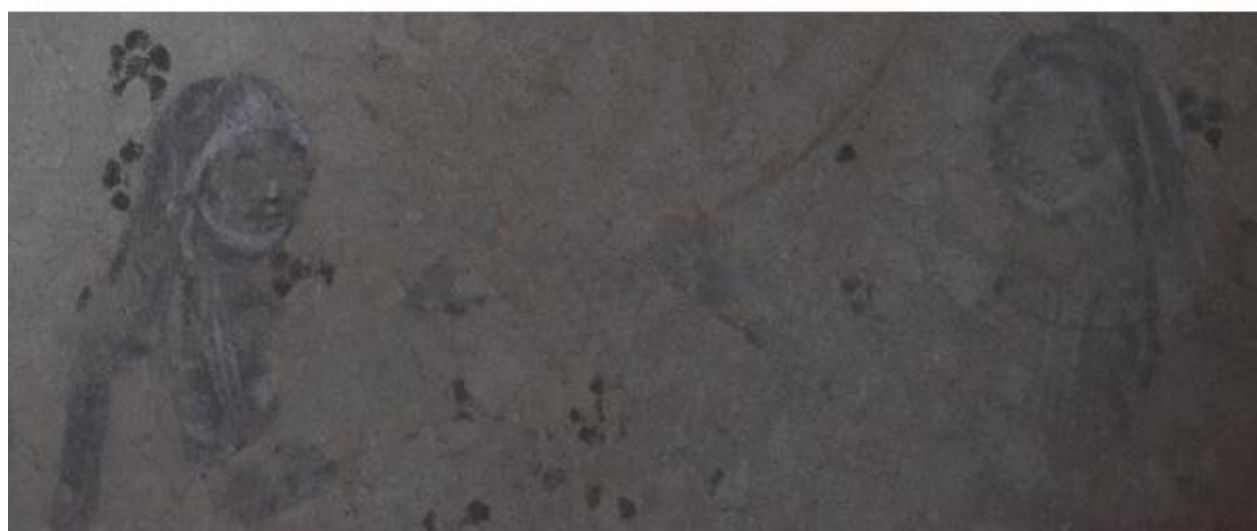
Příloha XXI. špaleta severního okna, detail
