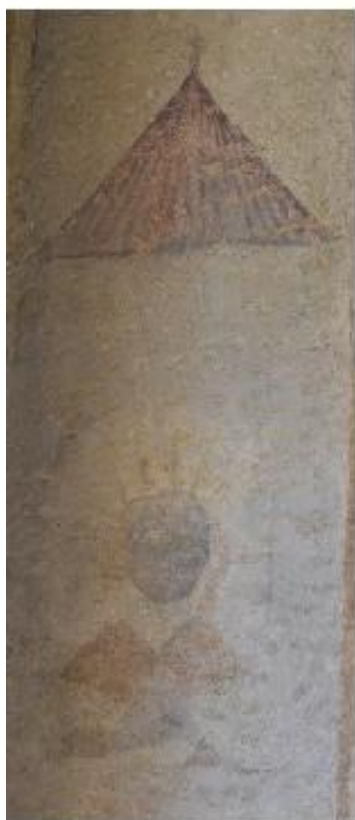
Příloha XIX. špaleta jižního okna foto: Julie Kamenská
