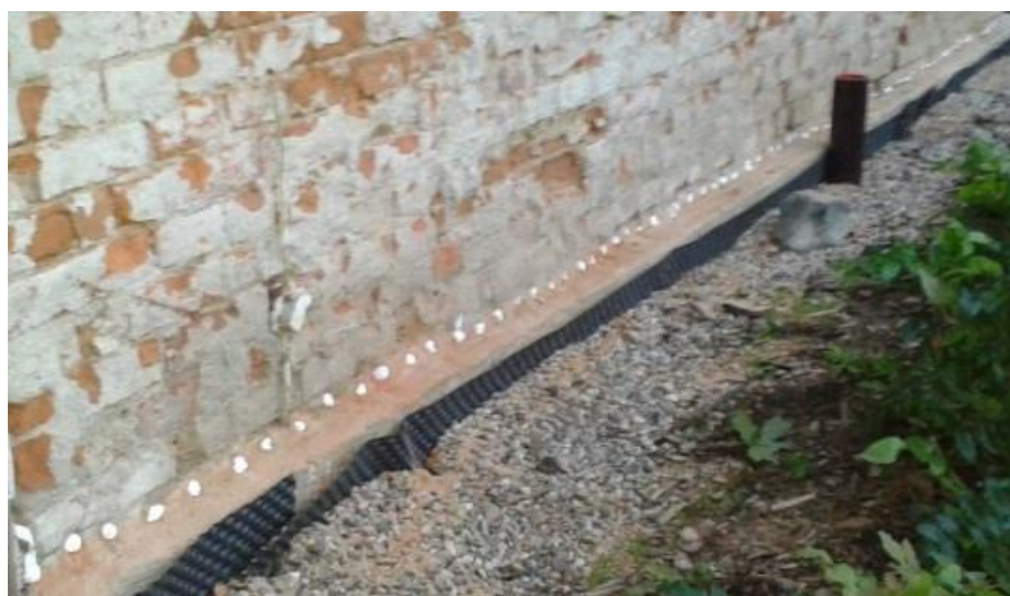
Obr. 35: Provádění injektáže beztlakovou metodou[27]
