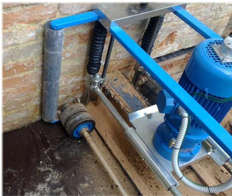
Obr. 28: Vkládání vodorovné hydroizolace metodou podřezávání zdiva[24]
