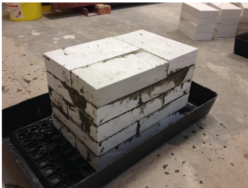
Obr. 77: Pórobetonový píliř vyzděný lepidlem
