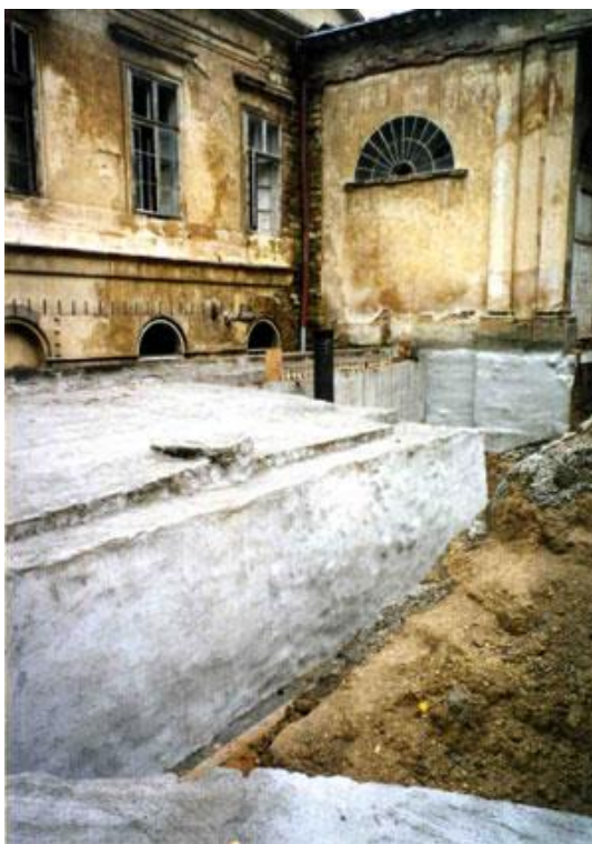
Obr. 17: Izolace zdiva jílovými vrstvami[17]
