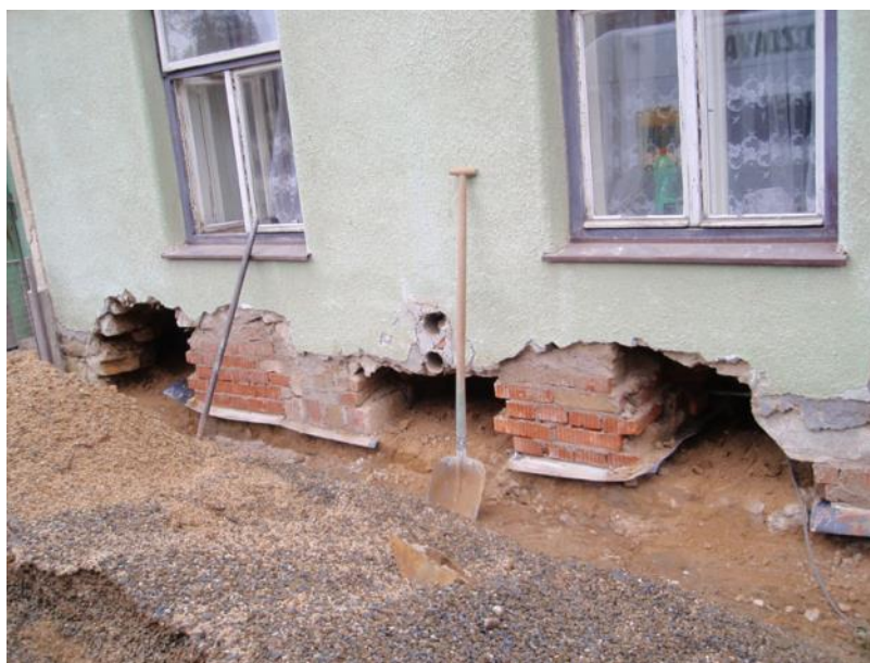
Obr. 27: Vkládání vodorovné hydroizolace metodou probourávání zdiva[23]
