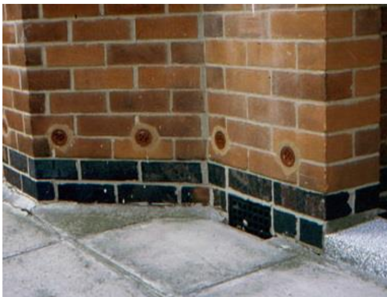
Obr. 14: Realizace sanace vlhkého zdiva prostřednictvím Knapenových kanálků[13]
