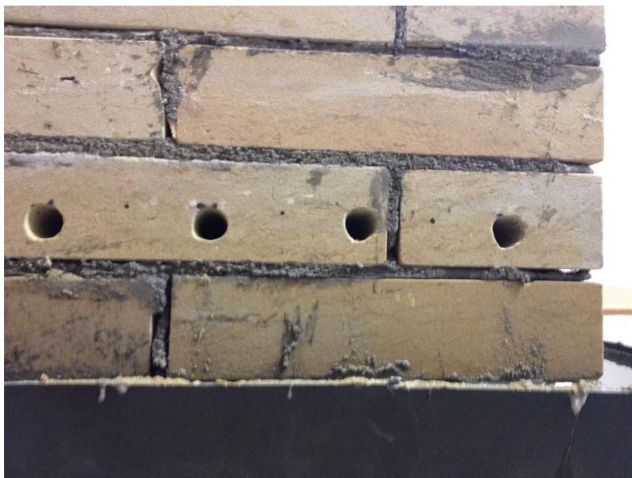
Obr. 80: Zkušební pilíř vyzděný z pískovcových cihel s připravenými injektážními otvory
