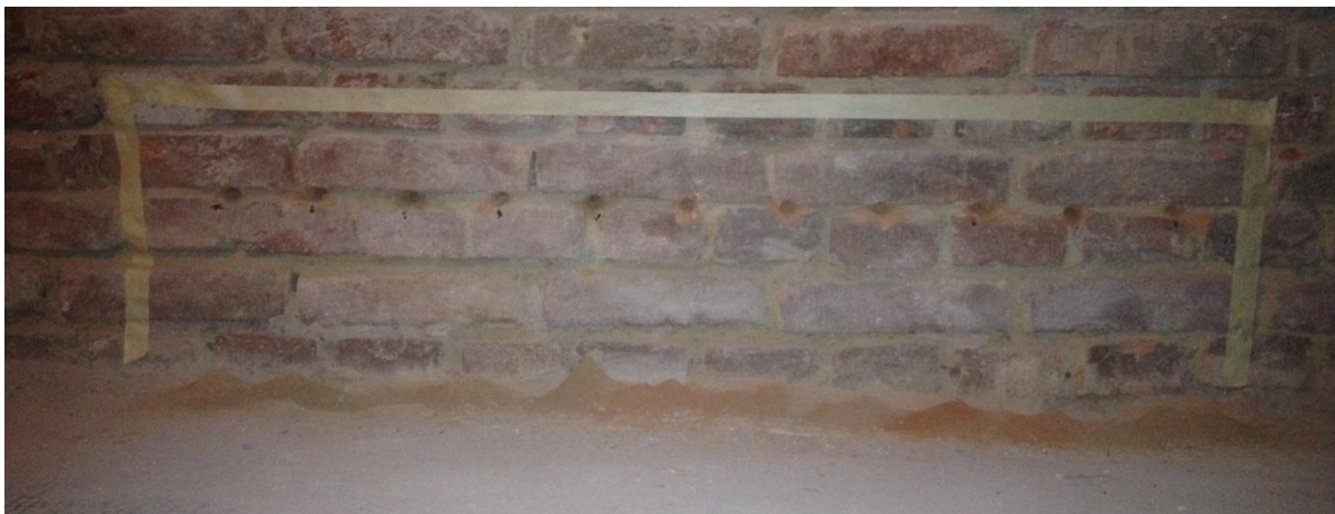
Obr. 89: Testovaný úsek s vytvořenými injektážními vrty
