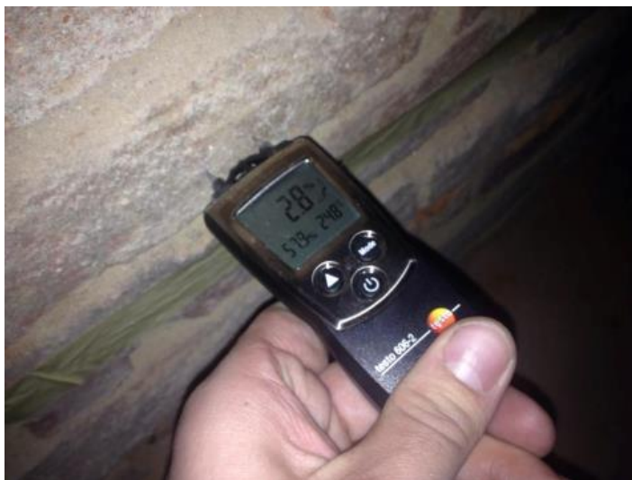
Obr. 88: Stanovení vlhkosti zdiva prostřednictvím odporového vlhkoměru
