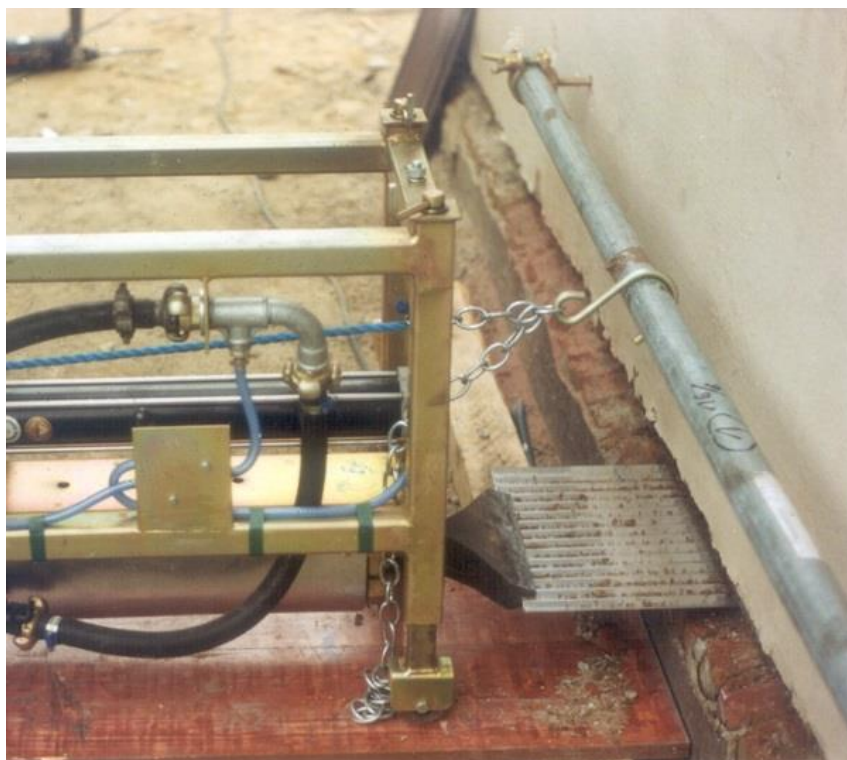
Obr. 29: Vkládání vodorovné izolace zarážením desek[25]
