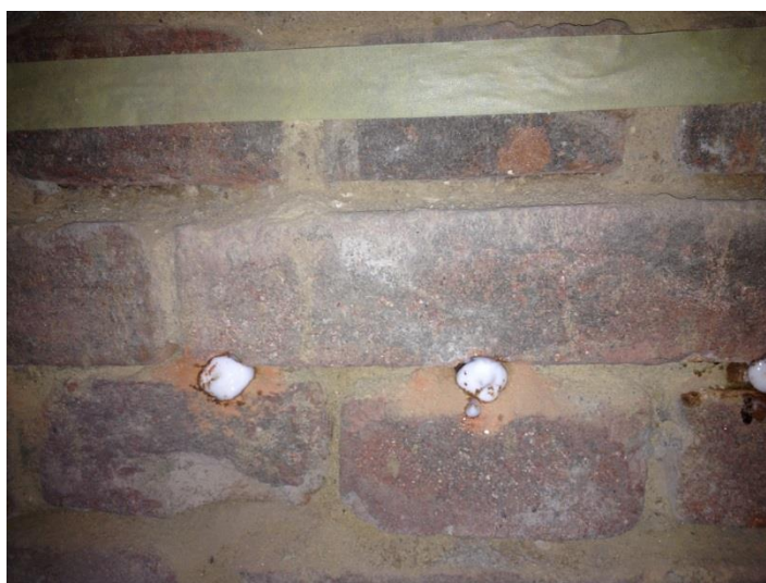
Obr. 90: Zkušební vrty s aplikovaným infuzním gelem
