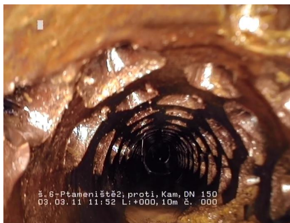
Obr. 3.8 Snímek vnitřní části kameninového drénu jímacího zářezu [24]
