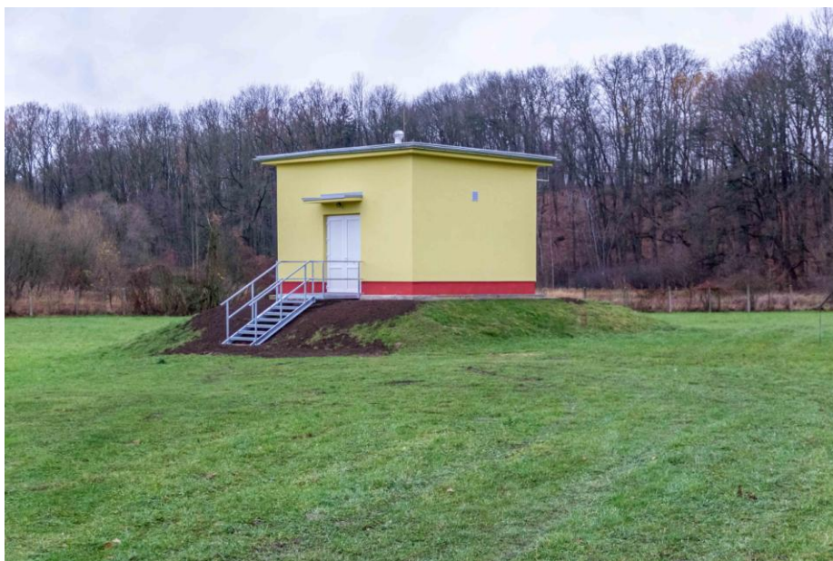
Obr. 5.1 Pohled na jímací objekt vrtu V8
