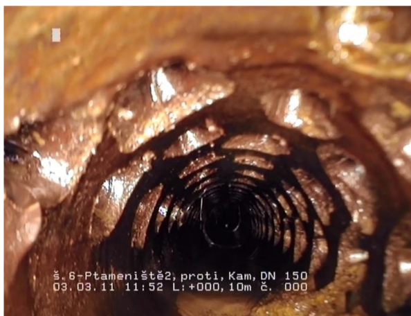
Obr. 3.8 Snímek vnitřní části kameninového drénu jímacího zářezu [24]
