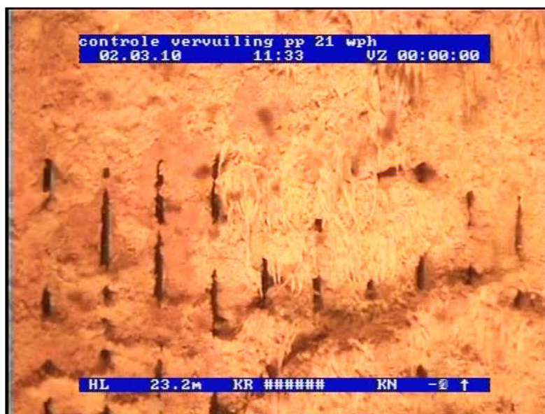
Obr. 4.12 Zanášení vtokových otvorů sloučeninami železa v perforované části zárubnice [29]
