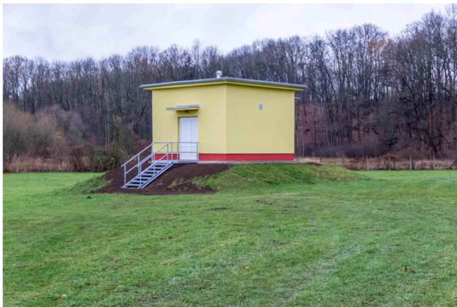
Obr. 5.1 Pohled na jímací objekt vrtu V8
