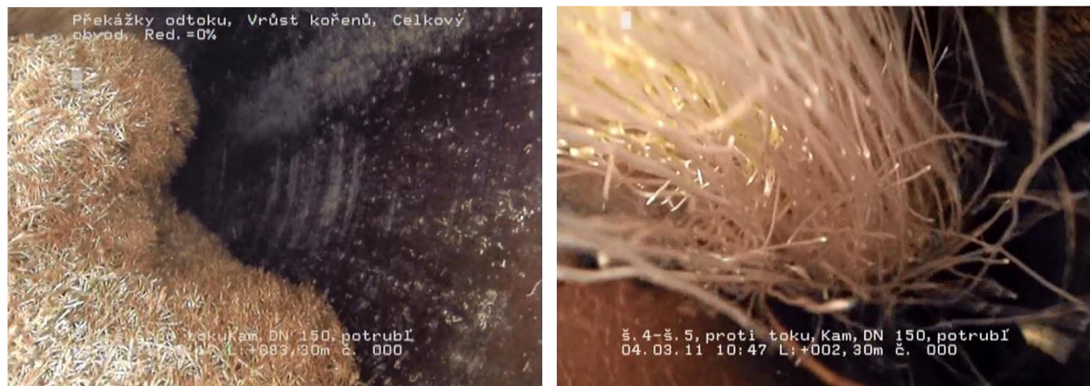
Obr. 4.8 Prorůstání kořenů do jímacího zařízení (jímací zářez) [24]
