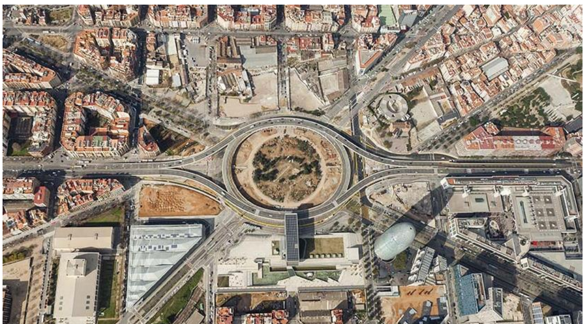
Obr. 8: Plaça de les Glòries Catalanes před demolicí (zdroj: Ajuntament de Barcelona, 2019)
