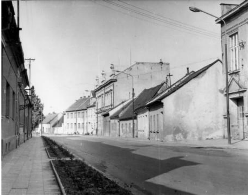
Obr.č.1 Tyršova ulice, Vyškov
