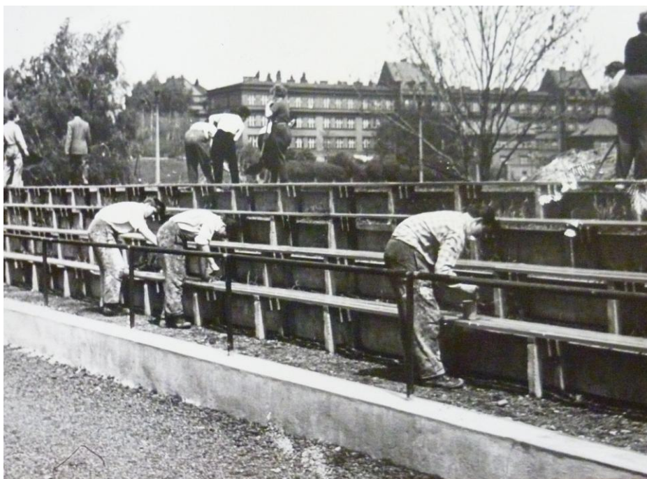
Obrázek 4: Výstavba fotbalového stadionu
