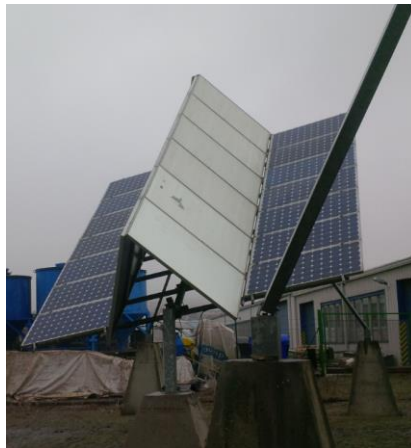
Obrázek 3.15: Tracker s koncentrátorem záření Super TRAXLE osazený čtrnácti fotovoltaickými panely (Zdroj: Archiv autora)
