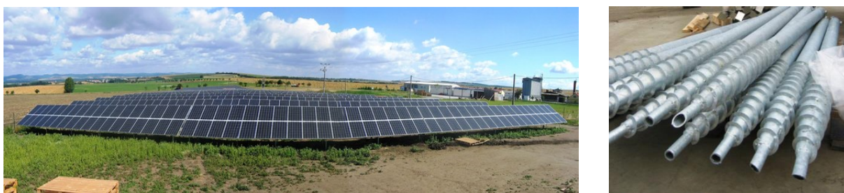
Obrázek 3.21: FVE v Ostrožské Lhotě a 1,6 m dlouhé zavrtávací šrouby použité ke připevnění konstrukce [49]
