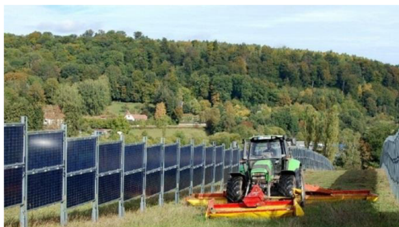
Obrázek 3.16: Instalace oboustranných panelů německou společností Next2Sun v zemědělské krajině [30]
