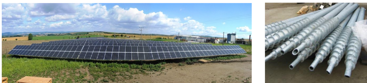
Obrázek 3.21: FVE v Ostrožské Lhotě a 1,6 m dlouhé zavrtávací šrouby použité ke připevnění konstrukce [49]
