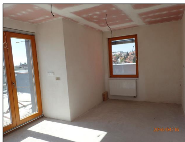
Pracovna před závěrečným dokončením
