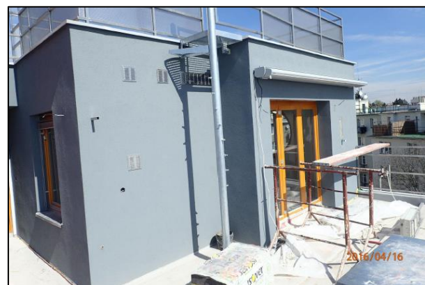
Nástavba před dokončení (před montáží vřetenového schodiště)
