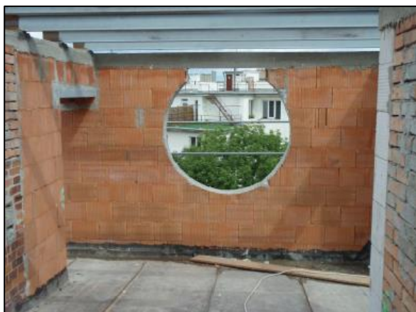
Vyždění kruhového okna
