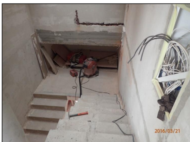
Vybudování schodiště do 7NP
