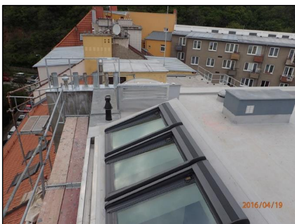
Střešní okna nad schodištěm
