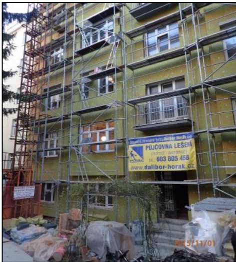
Zateplení objektu z ulice
