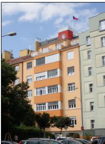
Finální úprava fasády z ulice
