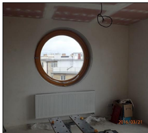
Kruhové okno v pracovně
