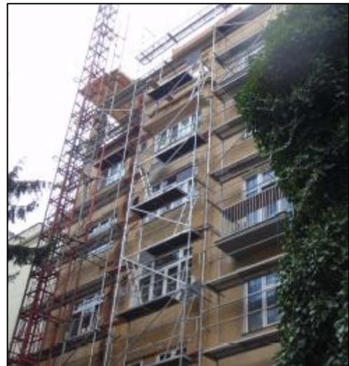
Zateplení objektu ze dvora
