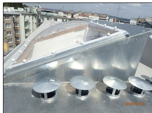
Oplechování střešního okna a odvětrání
