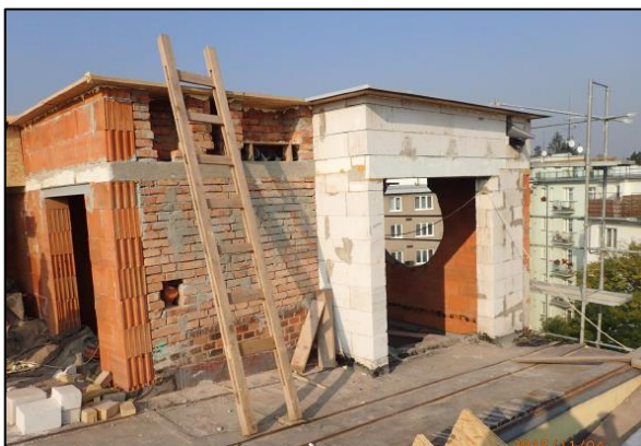
Průběh vybudování nástavby
