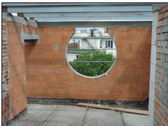
Vyždění kruhového okna
