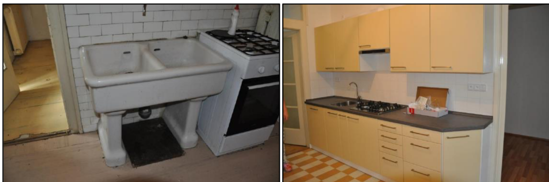
Obr. č. 18 - Fotografie kuchyně - Před a po opravě [42]
