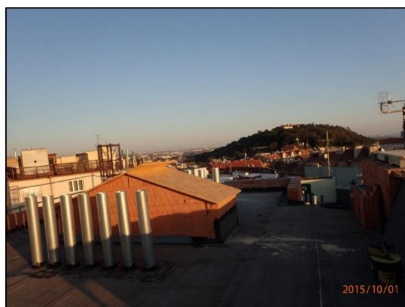
Vyústění komínů a odvětrání
