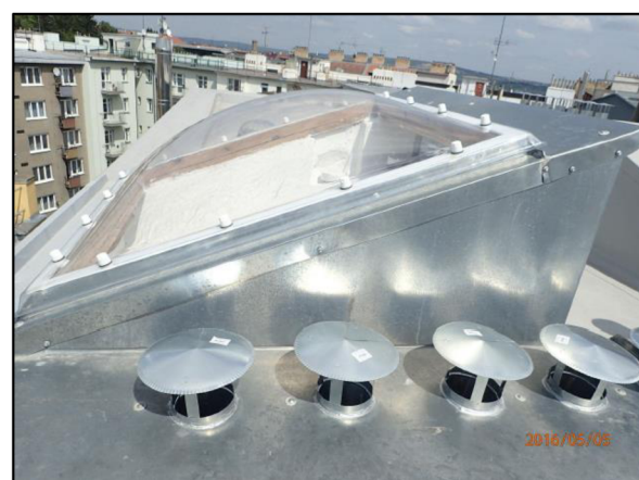
Oplechování střešního okna a odvětrání
