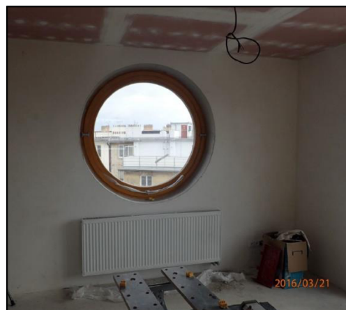
Kruhové okno v pracovně
