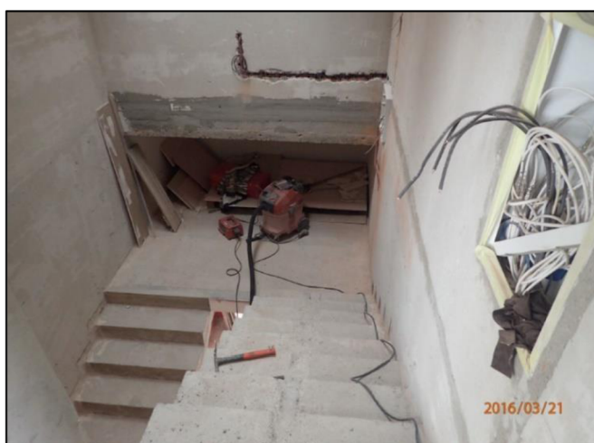
Vybudování schodiště do 7NP
