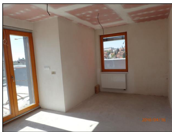
Pracovna před závěrečným dokončením
