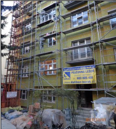
Zateplení objektu z ulice
