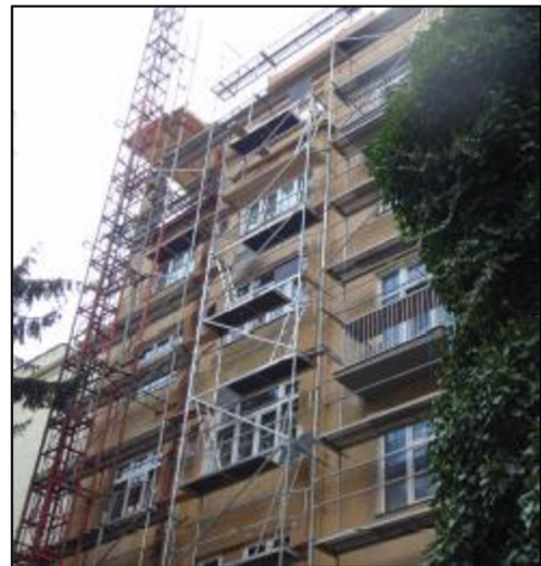
Zateplení objektu ze dvora
