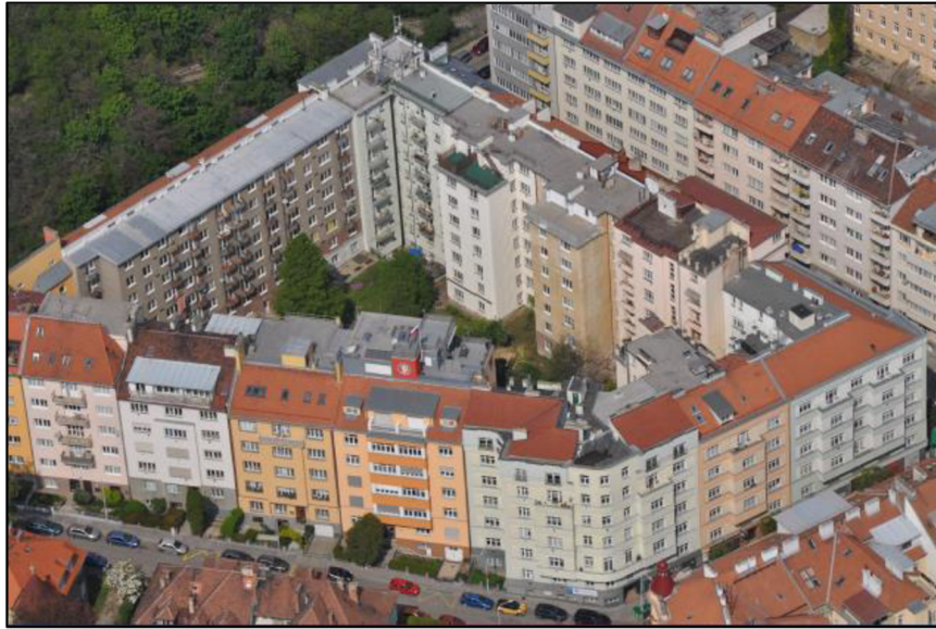
Obr. č. 21 – Letecký pohled [42]
