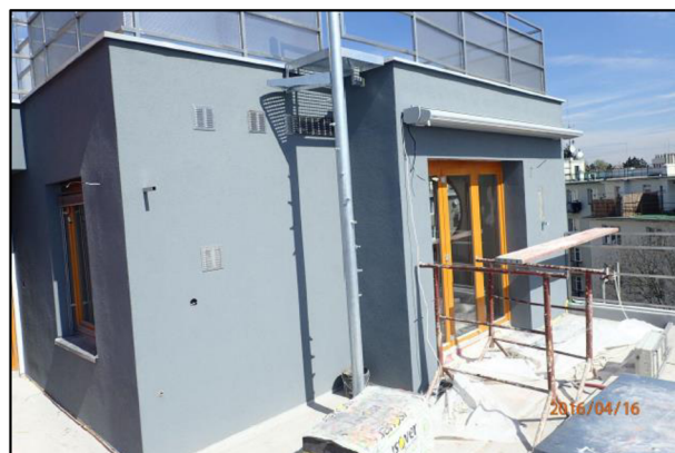
Nástavba před dokončení (před montáží vřetenového schodiště)
