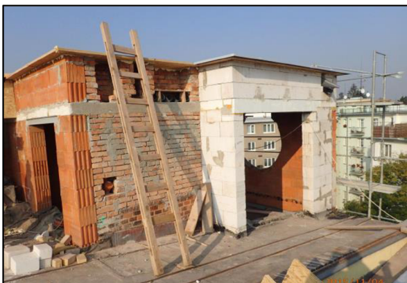
Průběh vybudování nástavby
