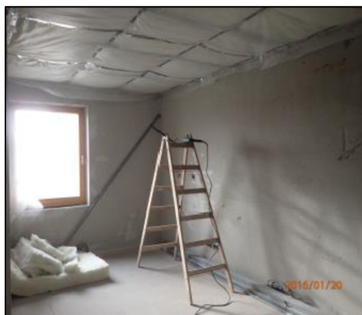
Zateplení stropu pracovny
