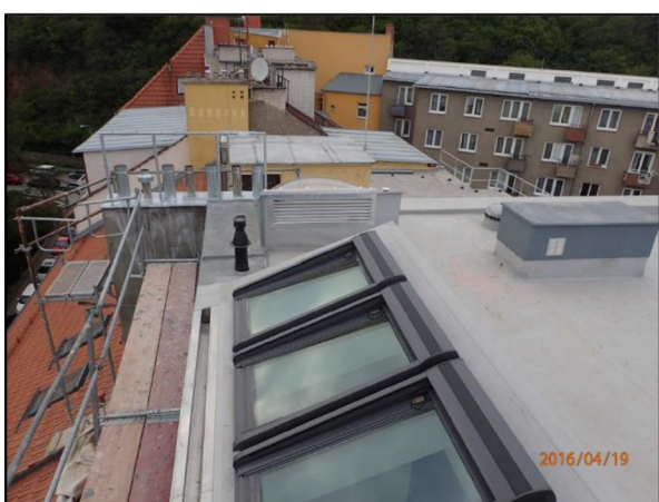
Střešní okna nad schodištěm
