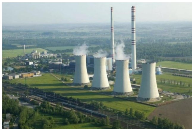
Obrázek 3: Tepelná elektrárna Dětmarovice, [3]
