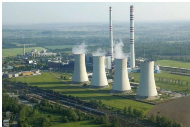
Obrázek 3: Tepelná elektrárna Dětmarovice, [3]
