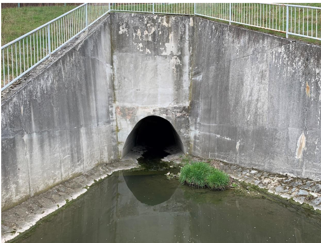
Obr. 10: Dálniční klenbová propust (pohled na vtok objektu).
