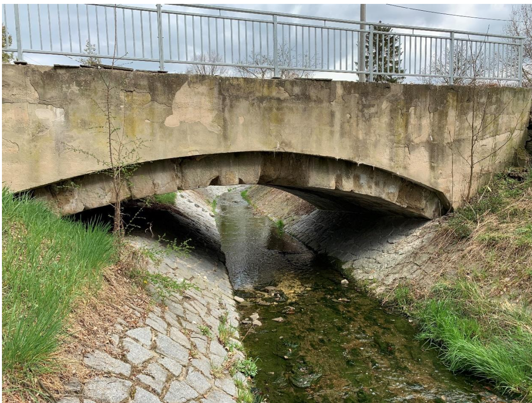
Obr. 8: Silniční mostek v Tuchoměřicích nad mateřskou školkou (pohled na vtok objektu).
