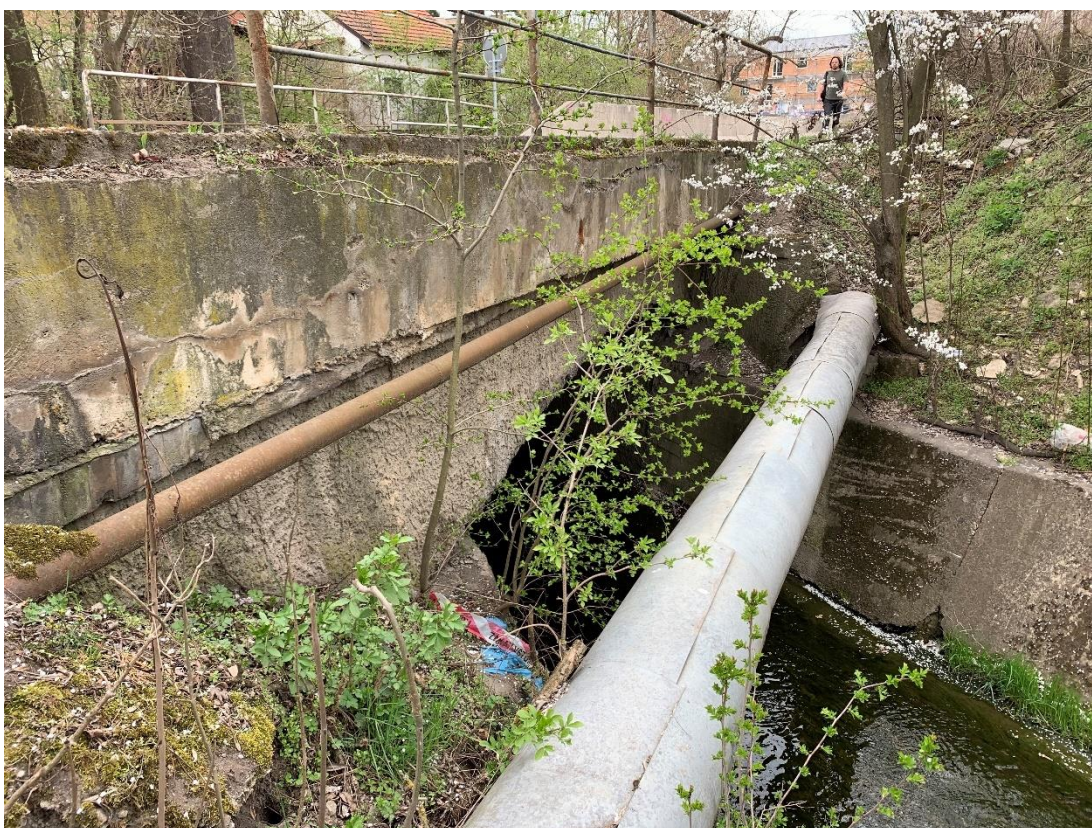
Obr. 9: Silniční klenbový mostek v Kněžívce (pohled na vtok objektu).
