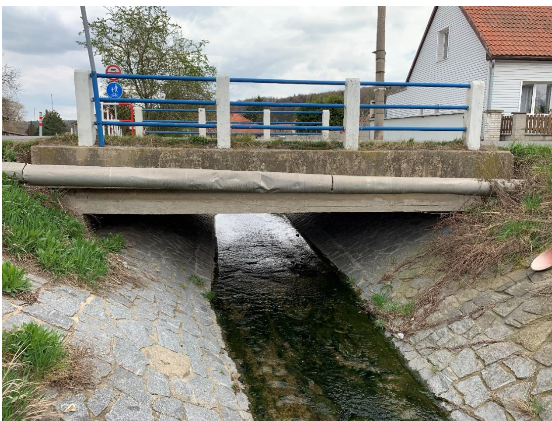
Obr. 7: Silniční mostek v Tuchoměřicích nad hřištěm (pohled na vtok objektu).
