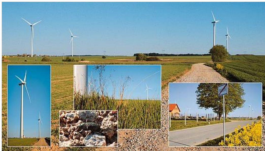
Obrázek č. 4: Větrná elektrárna Pavlov
