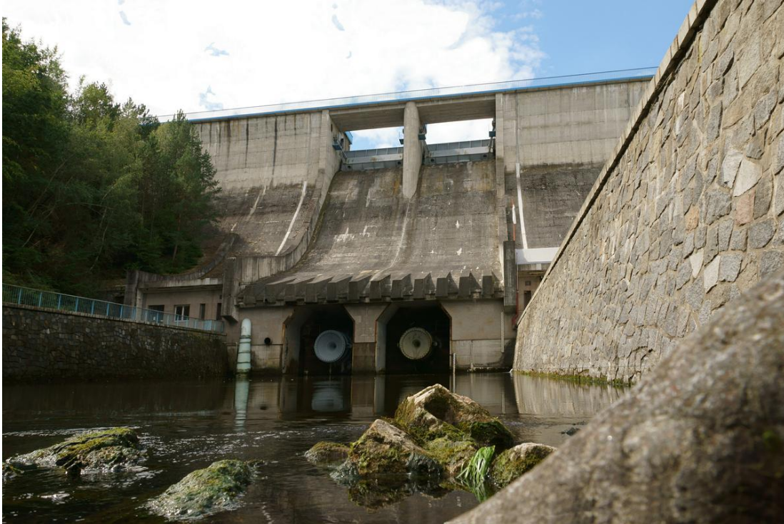
Obrázek č. 3: Vodní elektrárna Mohelno
