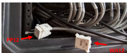
Obr. A.15 Porty pro realizaci horizontální linky
