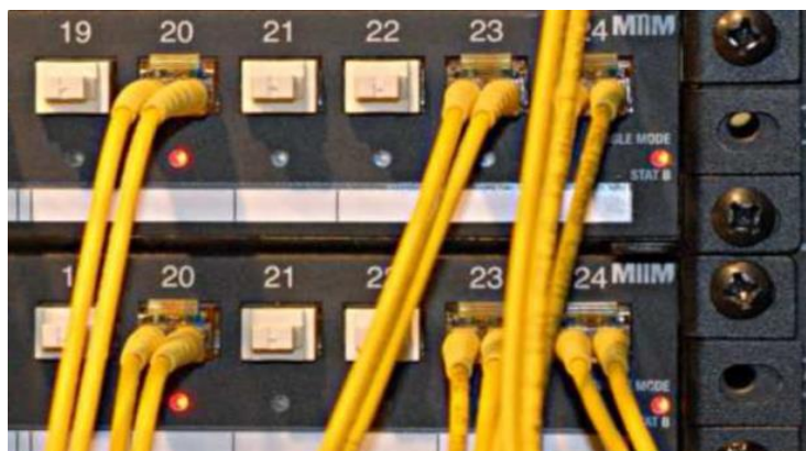
Obr. 4.15 Přední strana MIIM Fiber propojovacího panelu [9]
