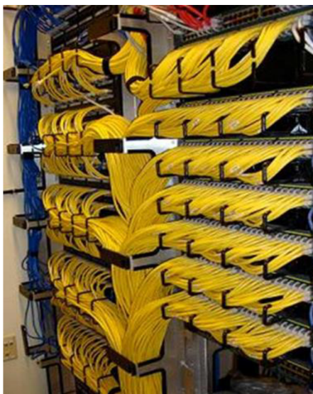
Obr. 2.2 Příklad řádně vedené správy kabeláže [1]
