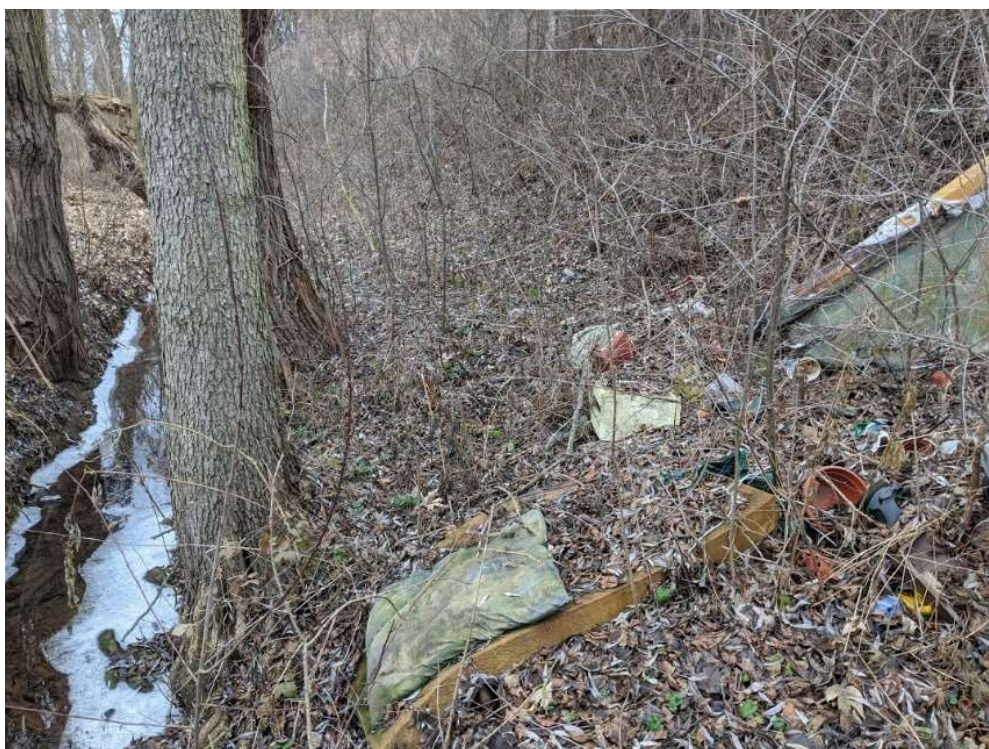
Obrázek č. 6: Příklad znečištěného koryta pod silnicí III/2214 (autor: Jan Lukáš, leden 2020)
