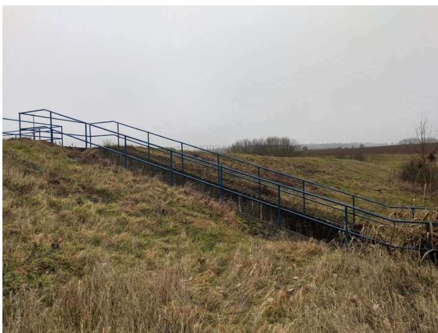
Obrázek č. 19: Návodní část hráze nádrže U Dubu (autor: Jan Lukáš, leden 2020)
