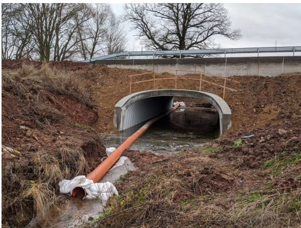
Obrázek č. 7: Most e. č. 2214-3 v rekonstrukci (autor: Jan Lukáš, leden 2020)
