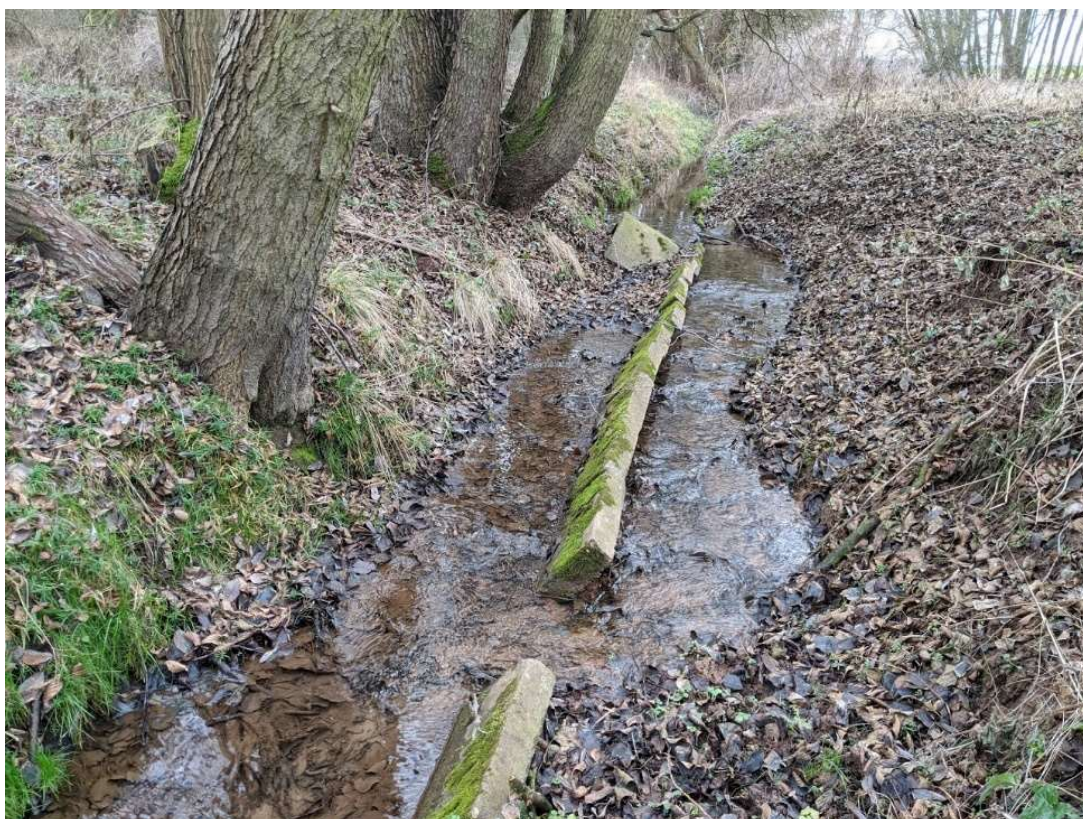
Obrázek č. 30: Opevnění ve špatném stavu, úsek pod Hořovičkami (autor: Jan Lukáš, leden 2020)
