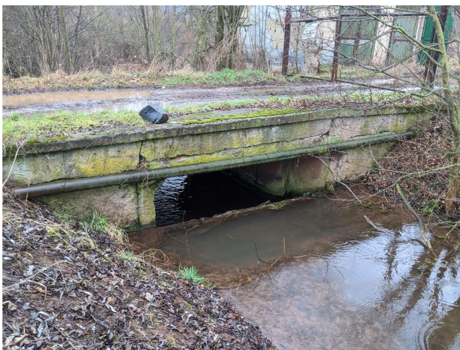
Obrázek č. 12: Mostek přes potok před zaústěním do Blšanky s vytvořením vzdutí hladiny (autor: Jan Lukáš, leden 2020)
