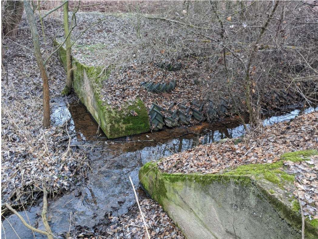
Obrázek č. 23: Opevněné koryto pneumatikami u Velké Černoce (autor: Jan Lukáš, leden 2020)
