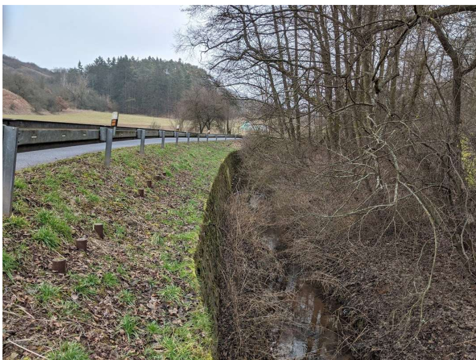
Obrázek č. 10: Opěrná kamenná zeď na komunikaci č. 221 (autor: Jan Lukáš, leden 2020)
