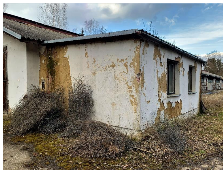
Fotografie – pohled na přístavbu (vlastní zpracování)
