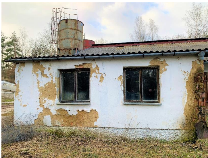
Fotografie – pohled na přístavbu (vlastní zpracování)
