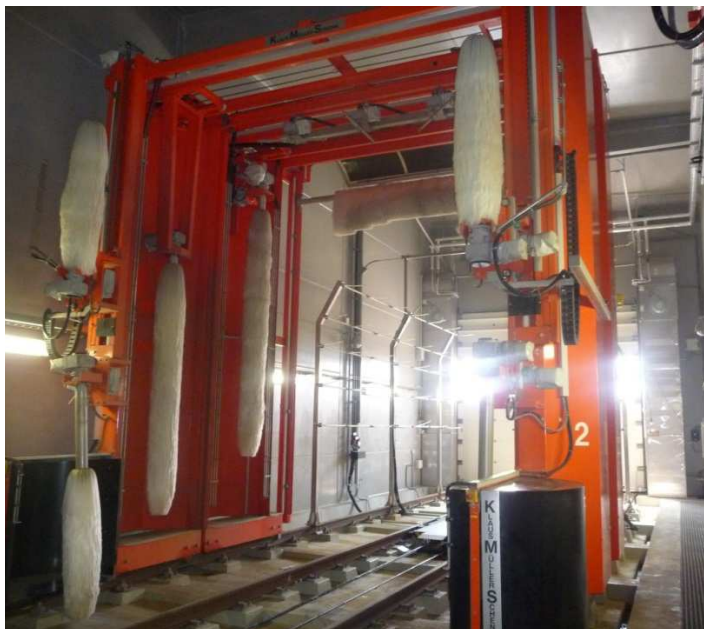
Obr. č. 15 – Mycí portály v myčce vlaků
