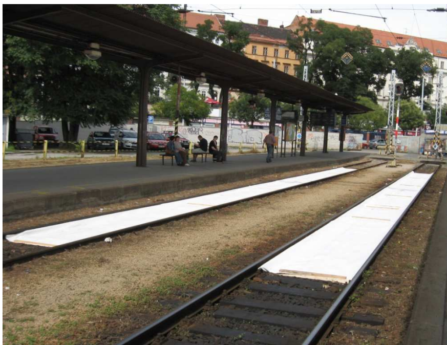
Obr. č. 8 – Ochrana železničního svršku proti úkapům z hnacích vozidel za pomoci sorpční textilie, Brno hlavní nádraží
