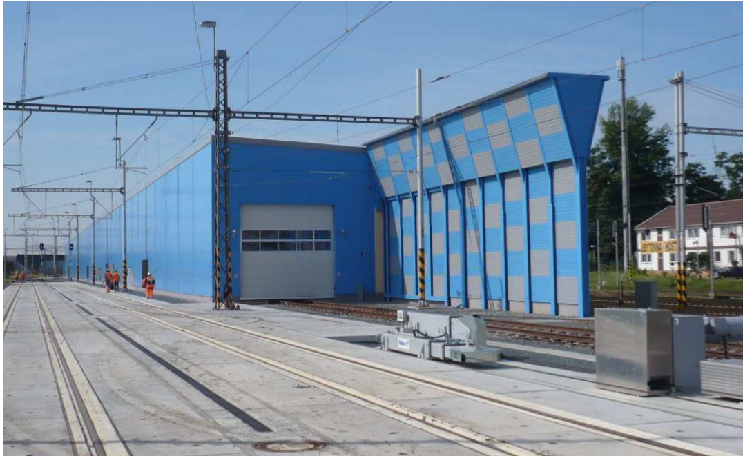
Obr. č.12–Venkovní pohled na myčku vlaků
