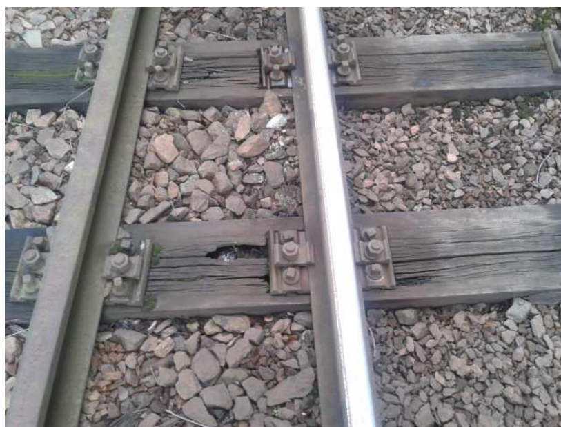
Obr. č. 7 – Dřevěné železniční pražce před výměnou
