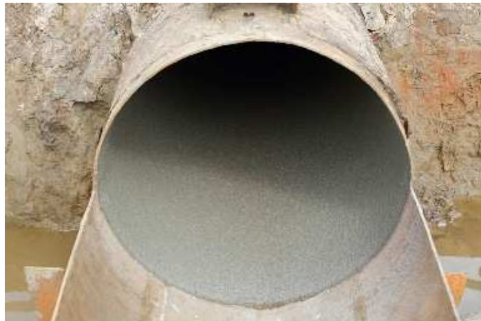
Obr. 7.5 Ukázka sanovaného potrubí cementací [38]
