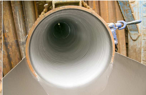
Obr. 7.7 Sanace SS systémem - výsledný stav [31]
