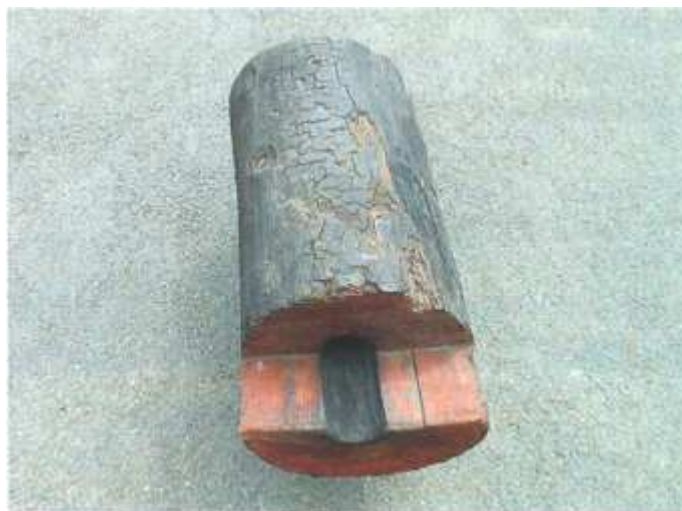
Obr. 5.3 Výřez z dřevěného vrtaného potrubí z r. 1825 nalezeného v Hranicích na Pernštejském náměstí [2]
