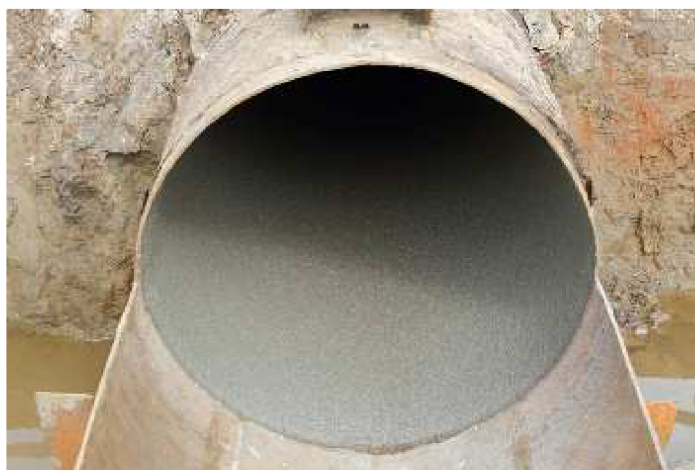
Obr. 7.5 Ukázka sanovaného potrubí cementací [38]
