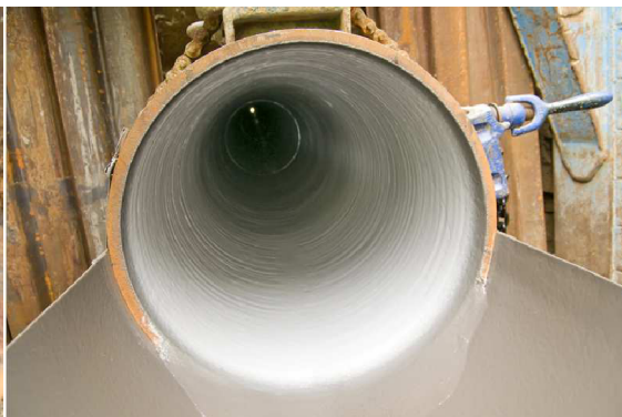
Obr. 7.7 Sanace SS systémem - výsledný stav [31]
