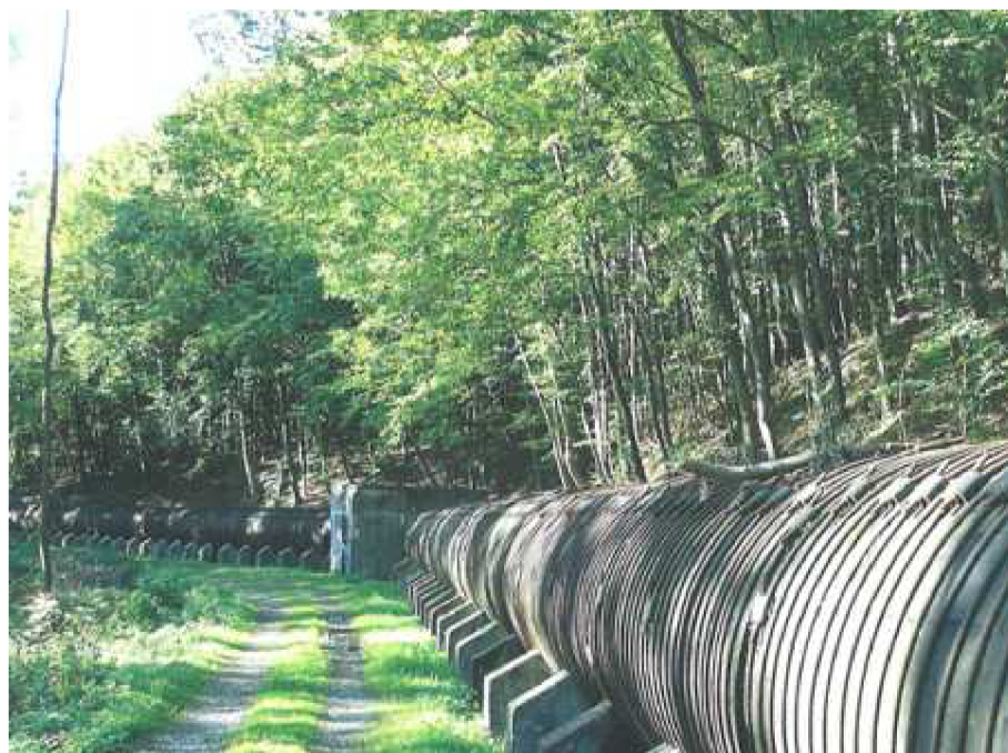
Obr. 5.5 Dřevěné dužinové potrubí DN 2000, převaděč z vodního díla Seč na vodní elektrárnu (v roce 2010 nahrazeno ocelovým potrubím) [2]
