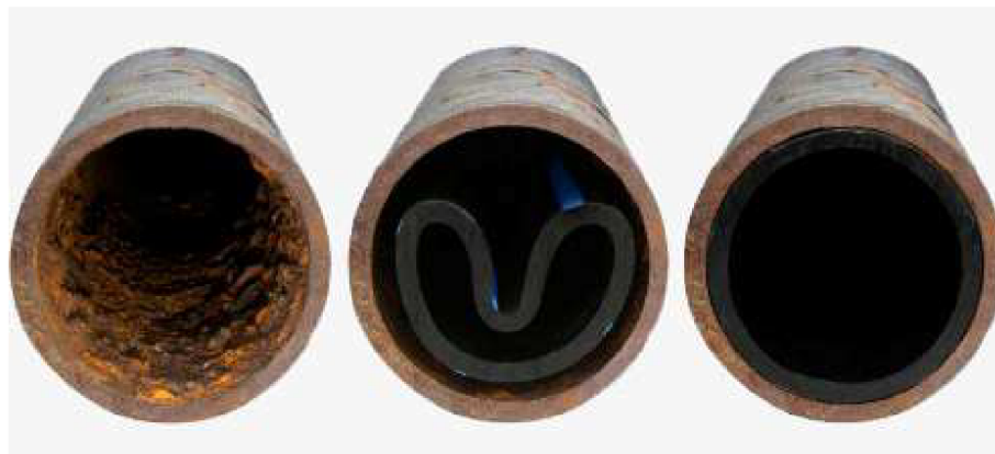
Obr. 7.9 Technologie U-liner. Zleva: nečištěné potrubí s inkrusty, zatažené zdeformované PE potrubí a výsledný stav [37]
