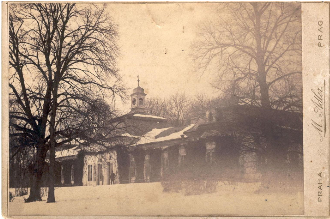
Obr. č. 25. Nový zámek. – Podklad: Archiv zámku Bon Repos (archiv bez evidenčních pomůcek).
