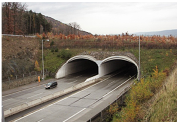
Obr.č. 8 - Ekodukt u Lipníka nad Bečvou ( www.selmy.cz )
