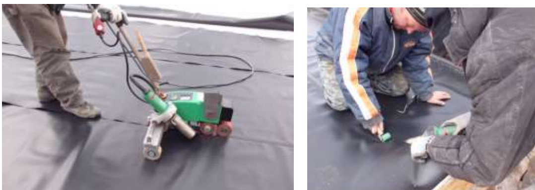
Obrázek 5,6 - Lepení izolace na bázi PVC
