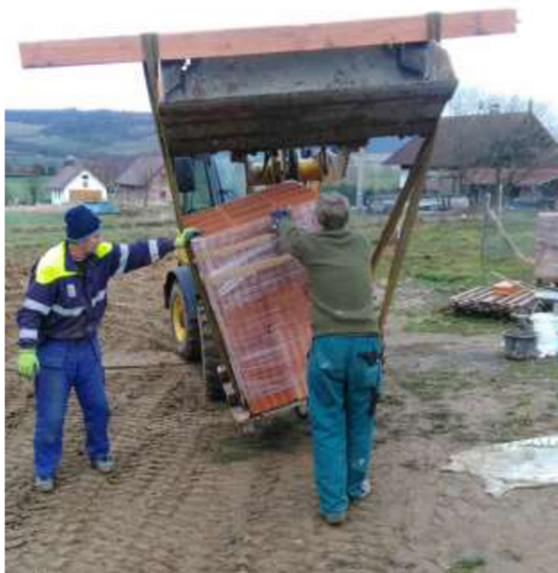
Obrázek 4 - Nevhodně zvolený přepravní prostředek
