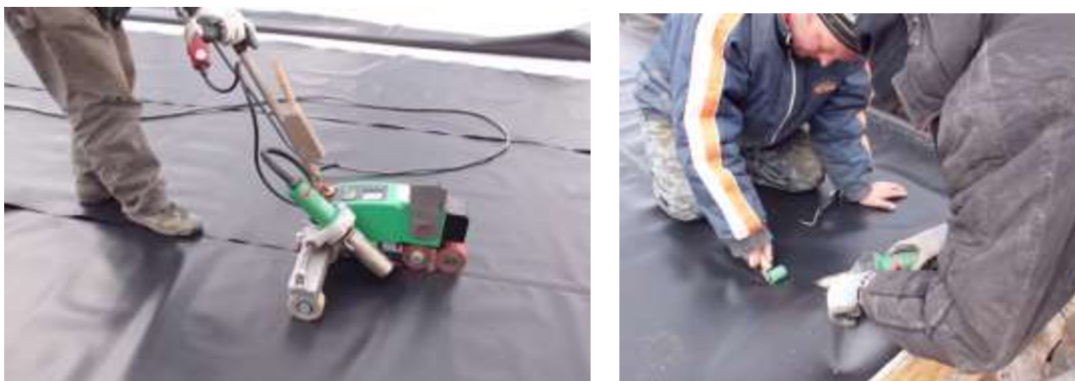
Obrázek 5,6 - Lepení izolace na bázi PVC
