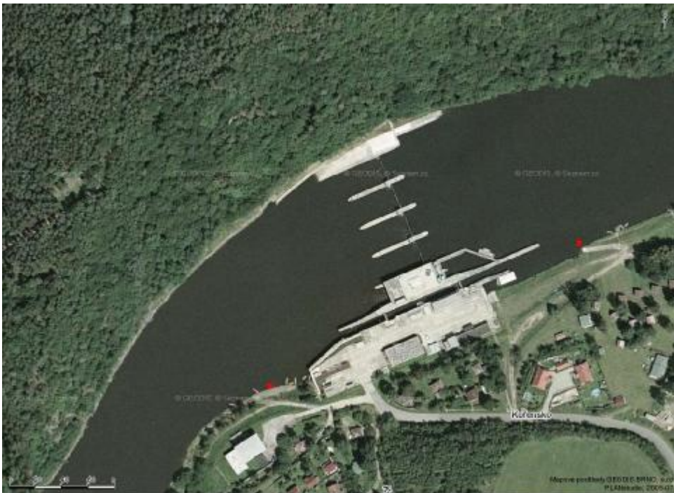
Příloha č. 3: Detail monitorovacího bodu Kořensko nad a Kořensko pod hrází
