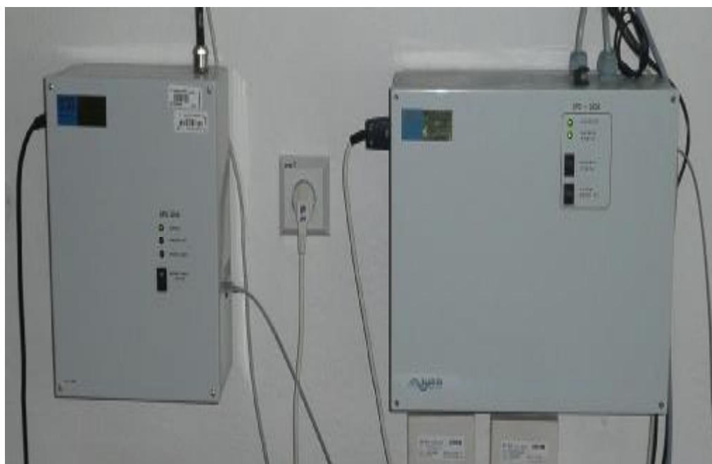
Příloha č. 19: Fotografie Ústředna a záložní napájení Sondy SVZ
