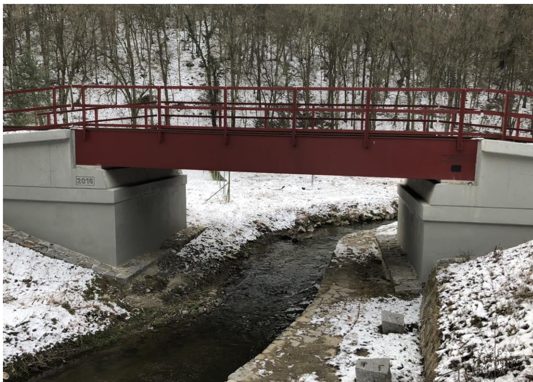
Obr. č. 6: Železniční most vybavený římsou pro průchod osob a zvěře. (autor Petr Matějka, 2018)
