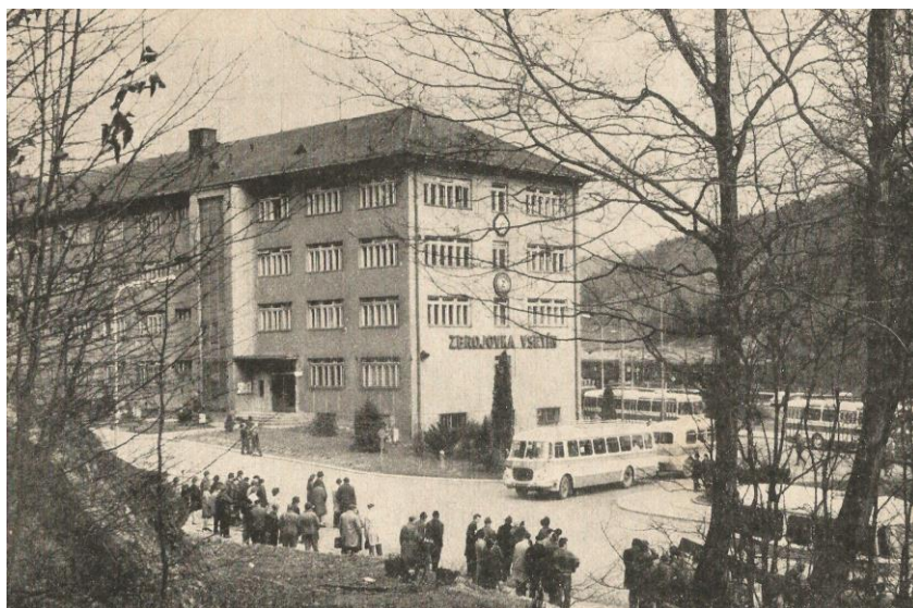
Správní budova Zbrojovky Vsetín (HAVLIŠ, Vladimír. 35 let národního podniku Zbrojovka Vsetín , Vsetín, 1972. s. 1)
