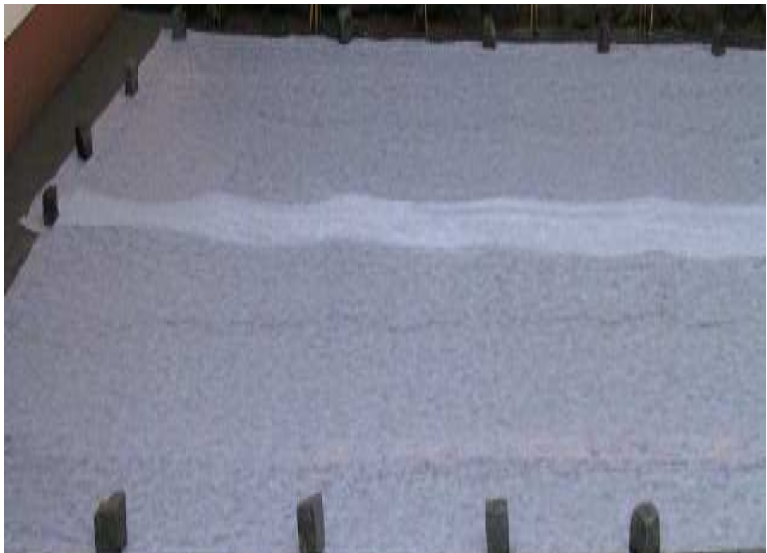
Obr. 8 – Pozemek po zasetí a zakrytí netkanou textilií v k.ú. Trhové Sviny
