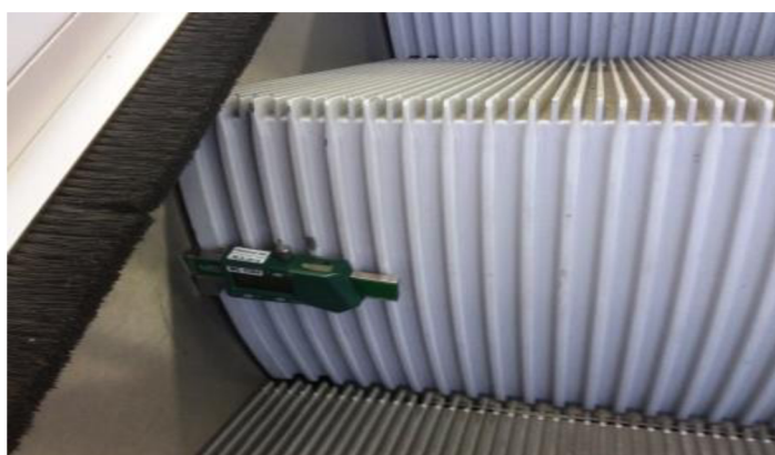
Obrázek 18 Měření na čele schodnice [13]
