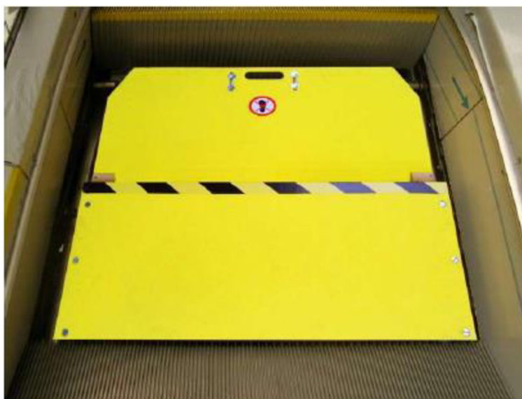
Obrázek 12 Bezpečnostní paleta v jednotce [11]
