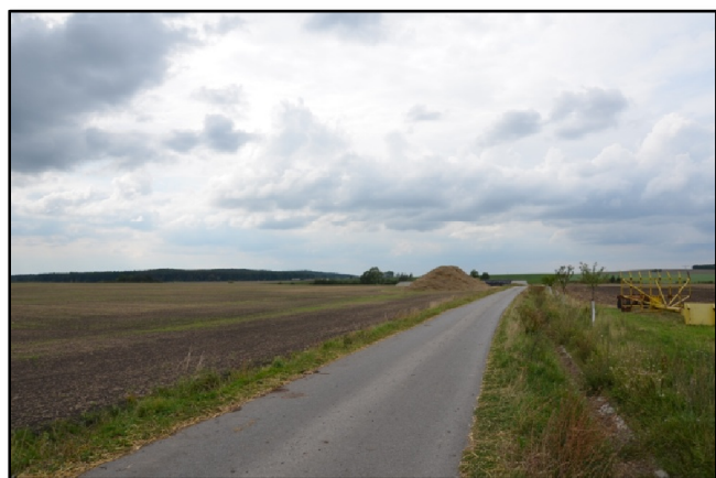
Foto. č. 12 Zpevnění cesty P6aCH asfaltovým betonem, odvodňovací příkopky a zeleň.
