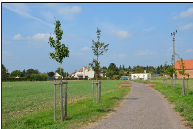
Foto. č. 38 Zpevněné hospodářské sjezdy cesty P2.
