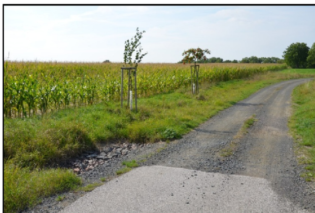
Foto. č. 49 Zarostlý příkop a místo určené k odvedení vody u cesty V 7.
