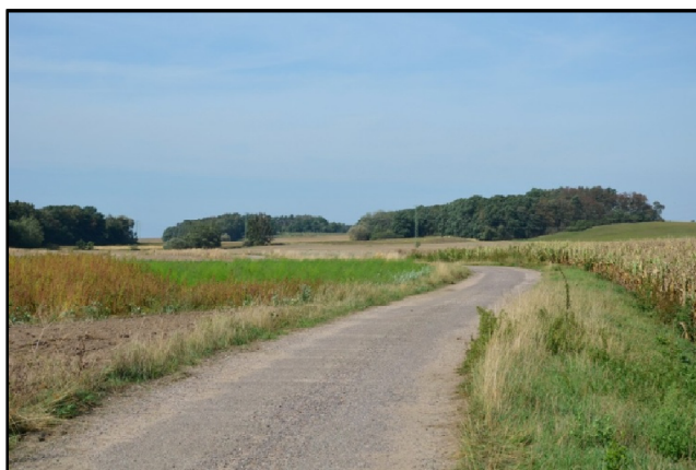
Foto. č. 1 Zpevněný povrch cesty P3.
