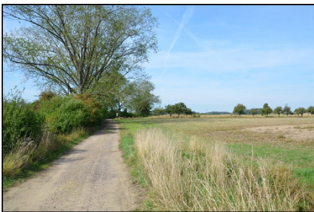
Foto. č. 5 Zpevněný povrch cesty Pv7 v nepoškozeném stavu.
