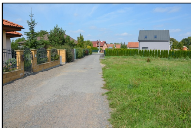
Foto. č. 41 Úsek cesty P9 vedoucí do zastavěné oblasti – asfaltbetonové zpevnění.
