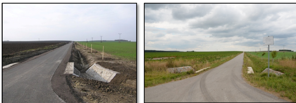
Foto. č. 22 a 23 Zeleň a příkopy podél cesty P24CH v době realizace a v současnosti. (Friš, P., pozemkový úřad, 2011, foto. č. 22)
