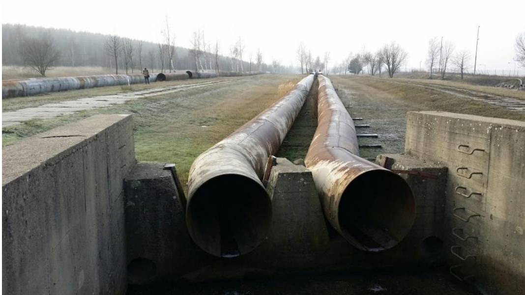
Obrázek 7 Řeka Bílina díky lomu vede potrubím
