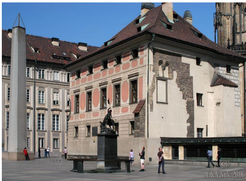
Obr. 18 Staré probošství v Praze s odhaleným románským sduženým oknem na barokní fasádě, 2006.
