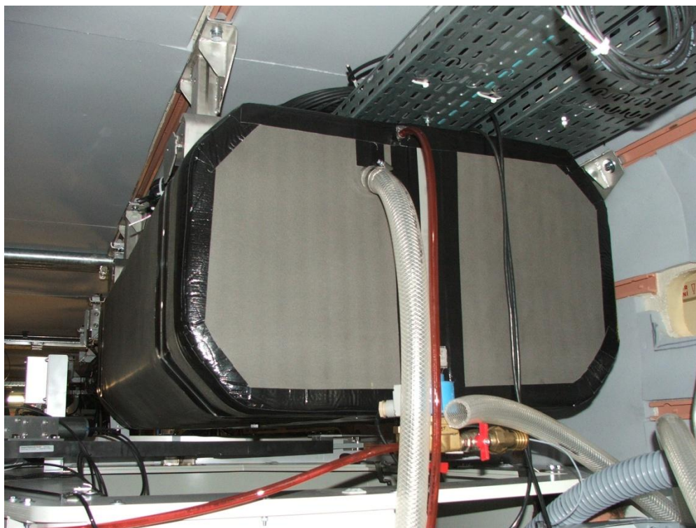
Obr. 2 Vodojem (foto: VKV Praha)
