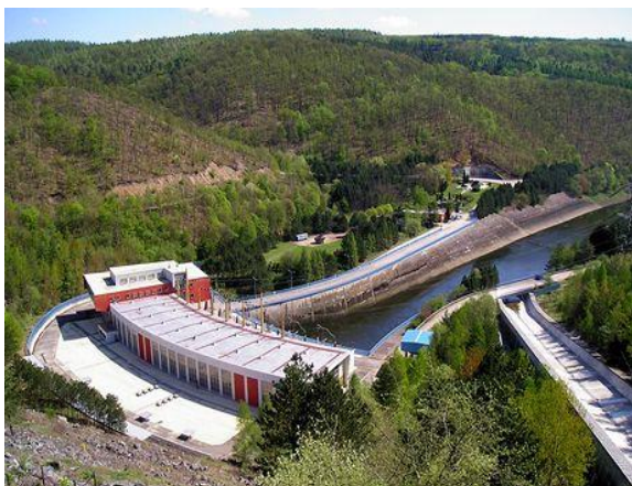
Obr. 9: Přečerpávací vodní elektrárna Dalešice (zdroj: http://cestovani.idnes.cz )
