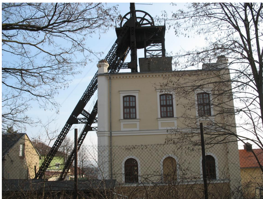
Zrekonstruovaná těžní věž dolu Simson ve Zbýšově, 2011 (foto Hana Staňková)
