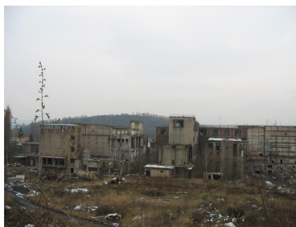
Obr. 16: Elektrárna Oslavany, pohled ze severní strany (foto Hana Staňková, 2010)
