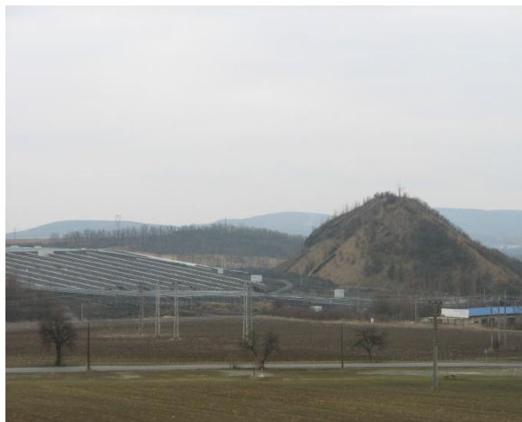
Obr. 20: Fotovoltaická elektrárna Oslavany (foto Hana Staňková, 2011)
