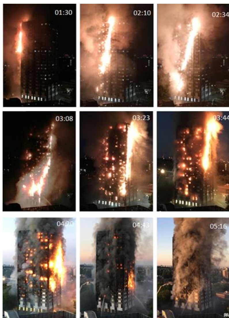
Obrázek 8 Šíření plamenů po výškovém domu Grenfell Tower v čase [9].
