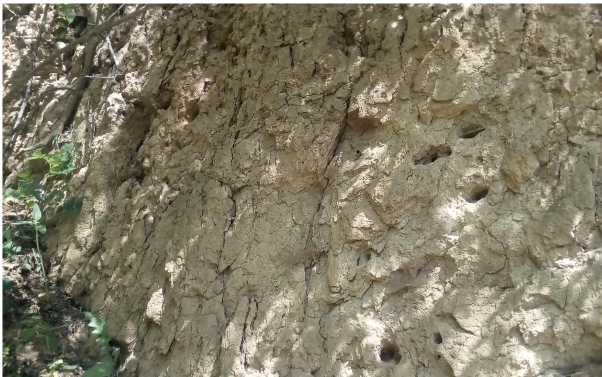
Snímek 11: Losky - stěna hlinišť - foto autor (27.5.2017)
