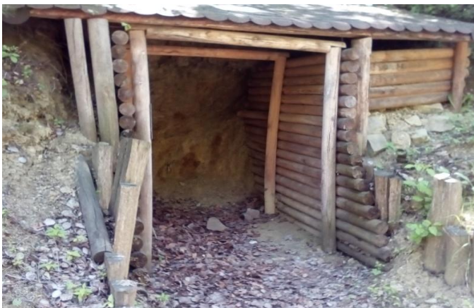
Obr.14: Borky - odkryv chráněný dřevěnou konstrukcí - (foto autor 27.5.2017)
