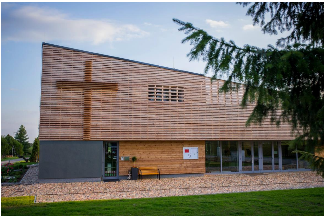
Obrázek č. 1 – Víceúčelové centrum Elada – Mateřská škola Trivium Plus (Grulich, 2016)
