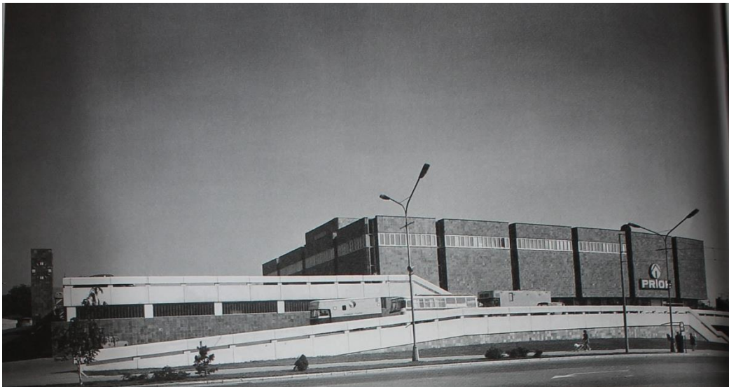
72. I. Matušík/ P. Lichard: Obchodní dům v Nitře, 1970–1974. In: Matúš Dulla/ Henrieta Moravčíková: Architektúra Slovenska v 20. storočí. Bratislava 2002, s. 215
