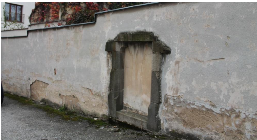
35. Gotický portál z domu čp. 4, který byl zbourán kvůli výstavbě obchodního domu Koruna. Památkáři požadované zachování proběhlo formou zazdění do zdi obslužného dvora. Foto: autor, 26. 10. 2018
