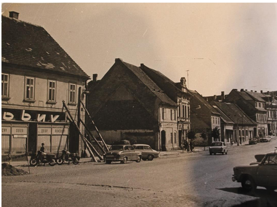
6. Pohled do třídy J. P. Koubka (Gottwaldovy ulice) v Blatné na domy určené k demolicí, aby uvolnily místo budoucímu obchodnímu domu Labuť, 1971. In: Městské muzeum v Blatné, fotografická sbírka, Blatná — Koubkova třída, náměstí Míru, inv. č. 724 (1–80), fotografie č. 30
