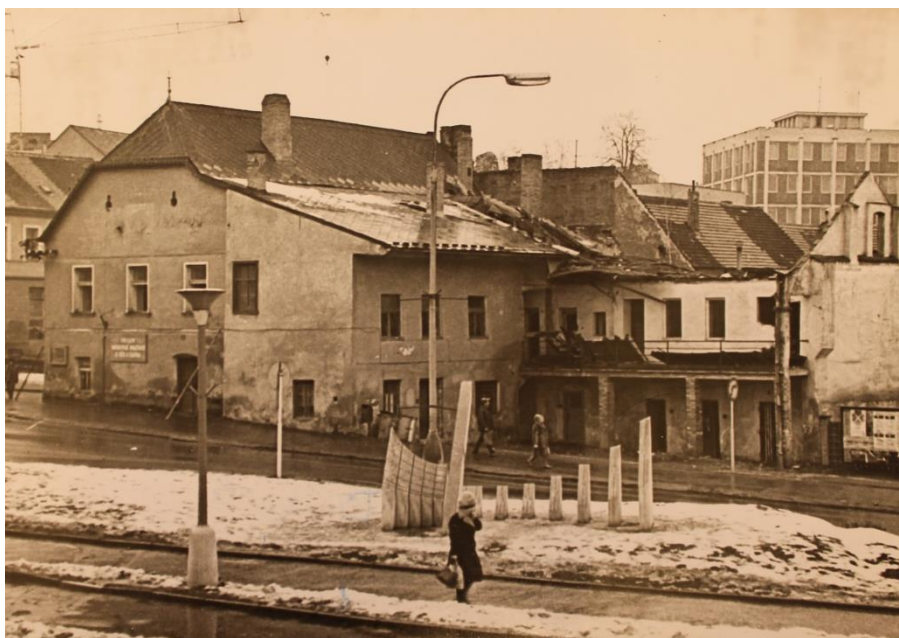
57. Malé náměstí (náměstí ČSA) v Prachaticích. Původní zástavba na místě budoucího obchodního domu Libín, leden 1979. In: Státní okresní archiv Prachatice, Fotografie — Prachatice, KT 15, Výstavba OS „Prior“ (Libín)1978–1985
