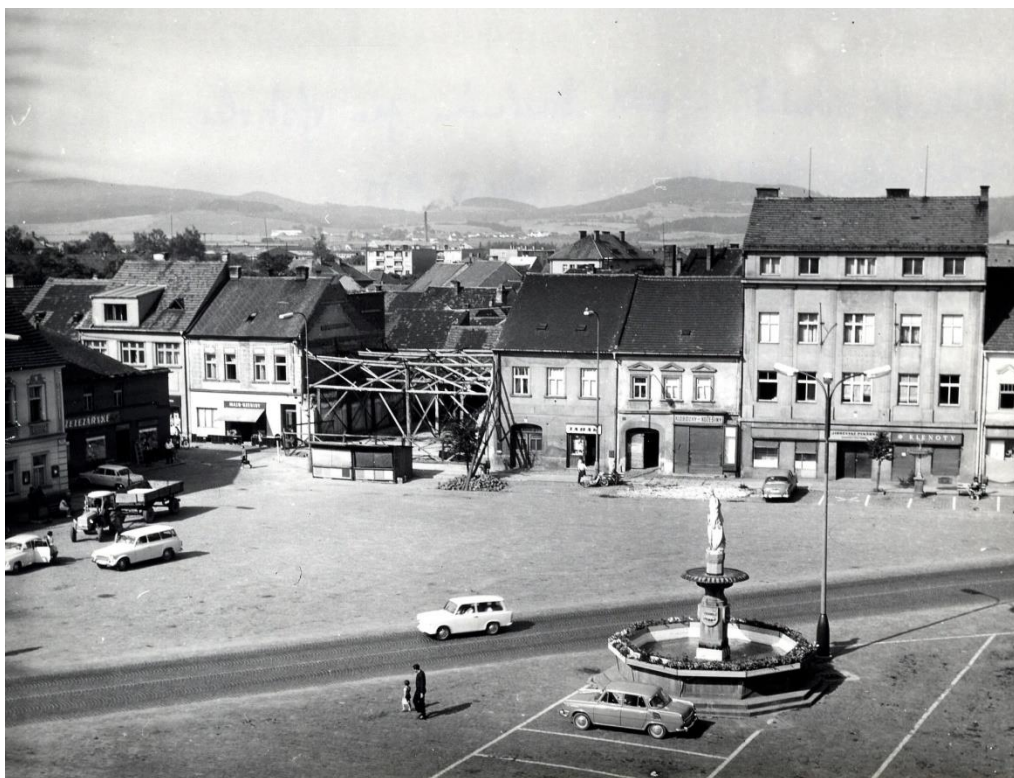
26. Náměstí ve Vodňanech. Hostinec U Koruny zbourán, proluku zpevnují dřevěné trámy. Dům napravo již zvýšen o dvě patra. In: sbírky Městského muzea a galerie ve Vodňanech
