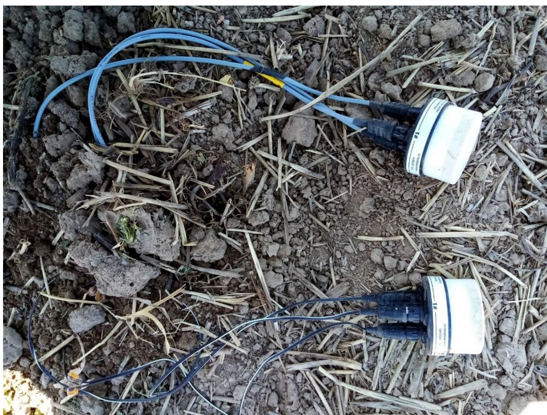
Obr. 20 Nainstalovaná a zapojená čidla
