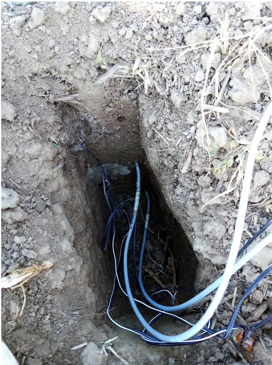
Obr. 21 Instalace čidel do půdy
